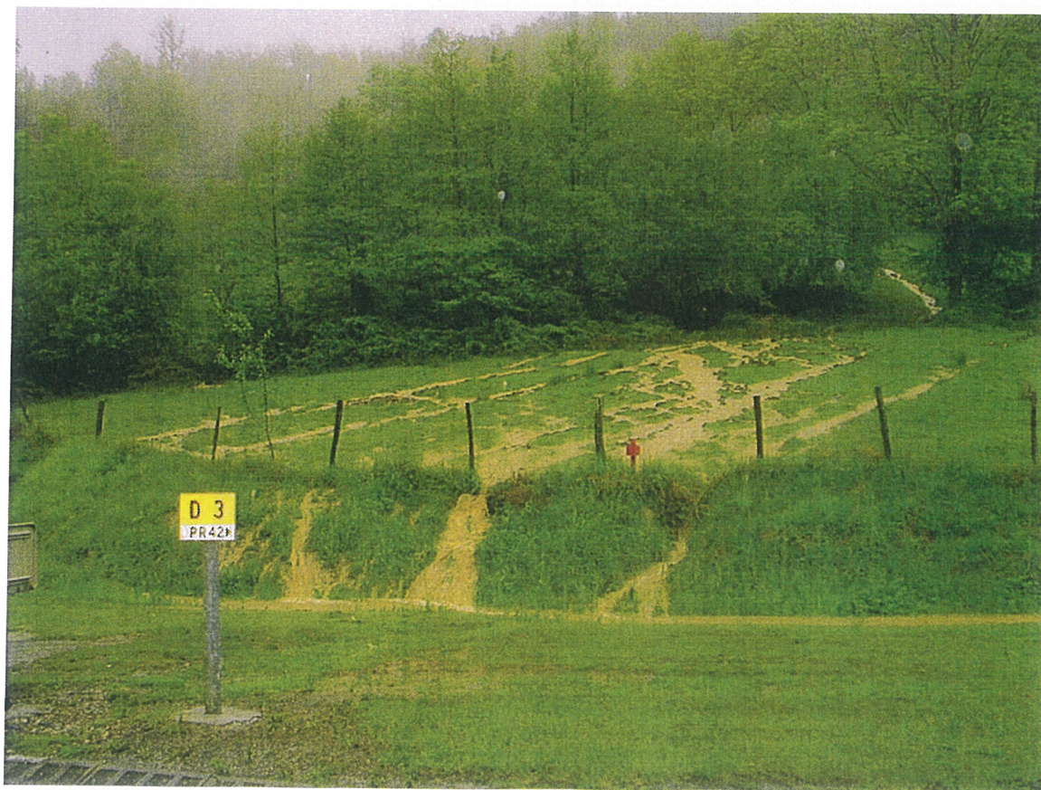
Photo 5 : Inondation par débordements des écoulements du talweg au niveau du rond point à la sortie d'Oust (Clichés RTM 09/31)
