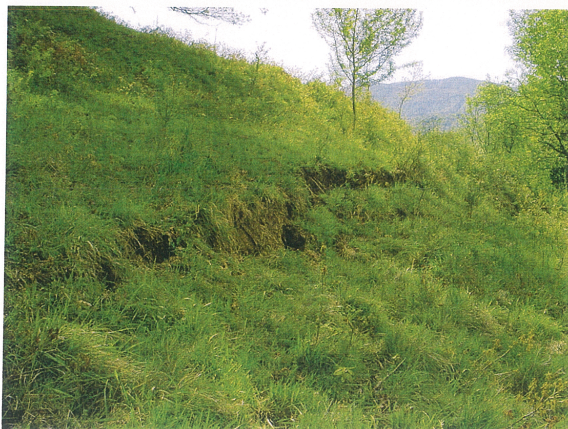
Photos 8 et 9 : Glissement de terrain directement en amont de la propriété Servat - 06/05/02 (Clichés RTM 09/31)
