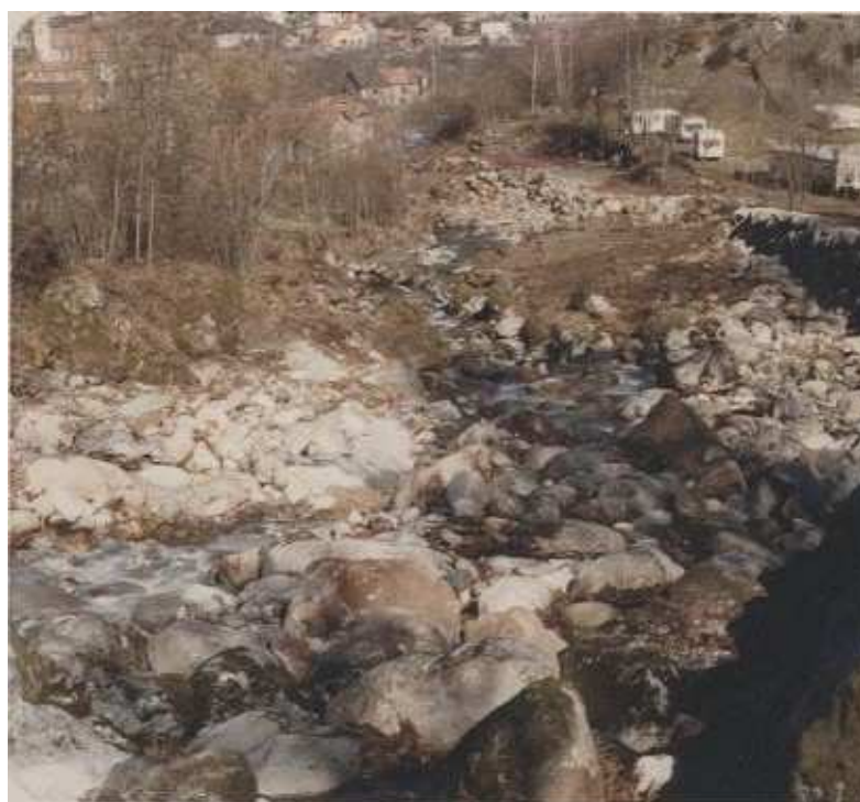
↑Chantier de construction de la digue de protection sur le Labail Mars 1990 Source : RTM 09-DF
