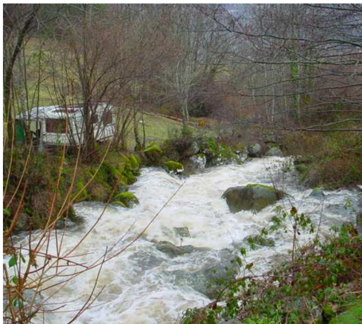
Crue du Labail : 24 janvier 2009 Source : RTM 09 - DF
