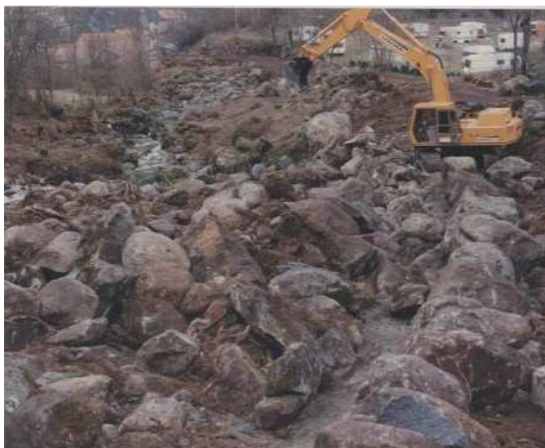
↑Chantier de construction de la digue de protection sur le Labail Mars 1990 Source : RTM 09-DF
