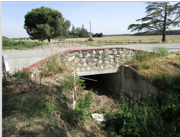
Figure 3.12: ouvrage hydraulique de la Galage sous la RD14 ; on notera sa faible ouverture.
