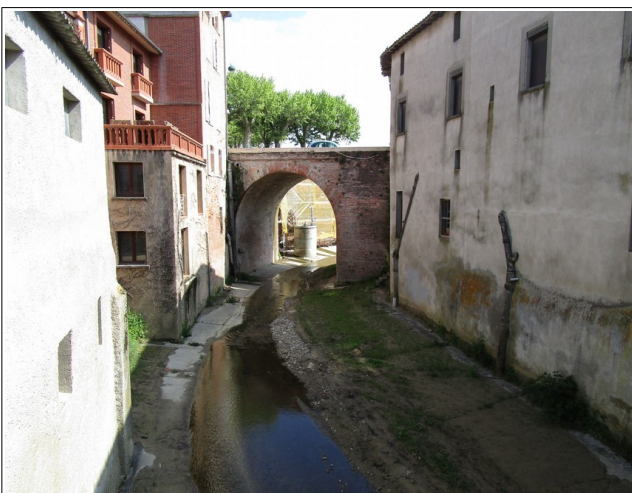
Figure 3.23: ruisseau de Lansonne dans la traversée du bourg de Saverdun (zone la plus étroite).
