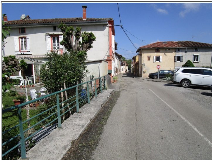
Figure 3.34: débouché d'une combe dans le quartier de Sainte-Colombe. La combe est busée sous la propriété à gauche de la photo ; elle peut l'inonder ainsi que la route.
