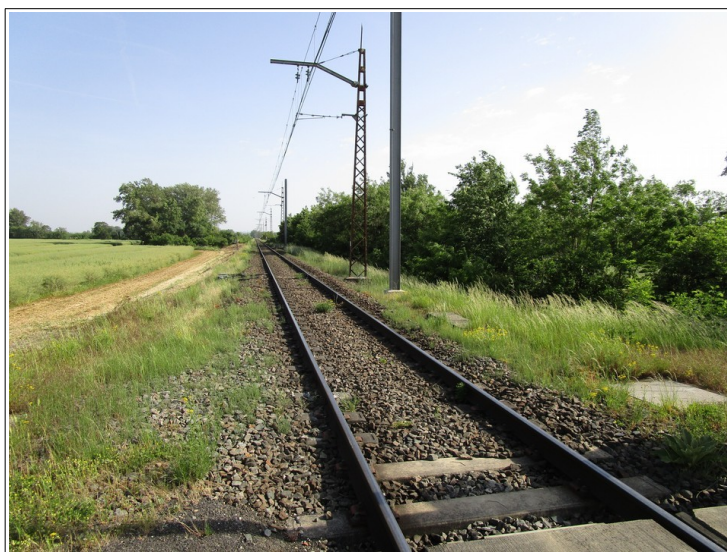
Figure 3.13: voie ferrée en remblai contenant le champ d'inondation du Crieu (à gauche sur la photo).
