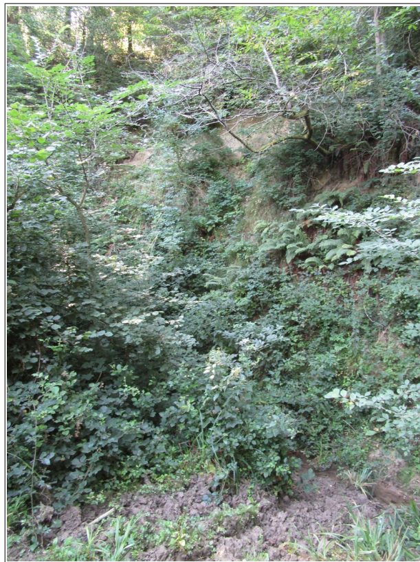
Figure 3.50: combe de Camusou ; érosion visible à la base du versant de la rive droite.
