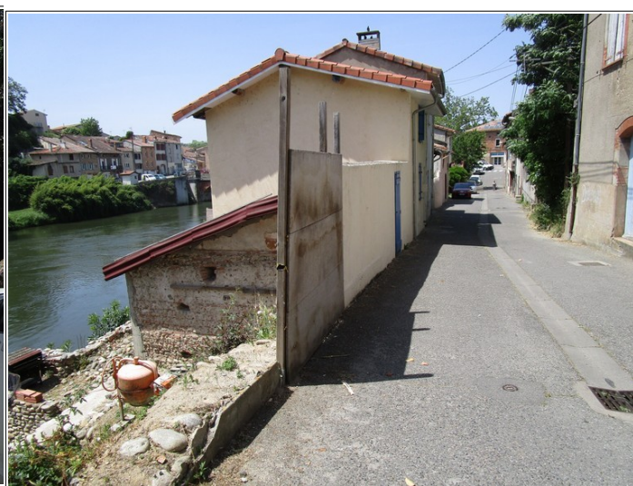
Figure 3.7: rue de la Croix-Blanche en rive droite de l'Ariège, à l'amont du pont de la RD14.
