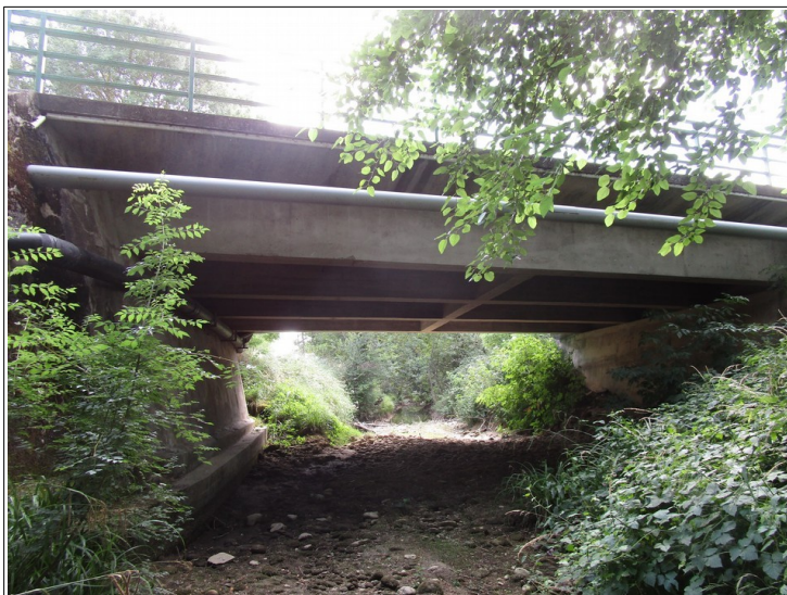
Figure 3.27: pont de la RD 927.
