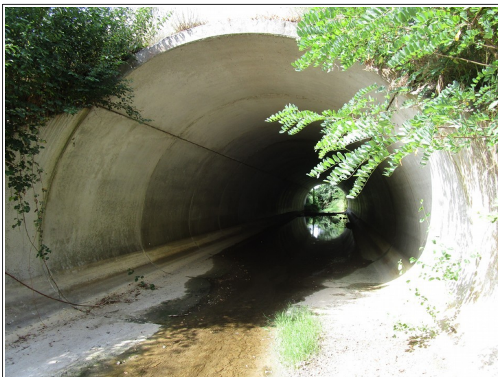
Figure 3.28: ouvrage de la RD820.
