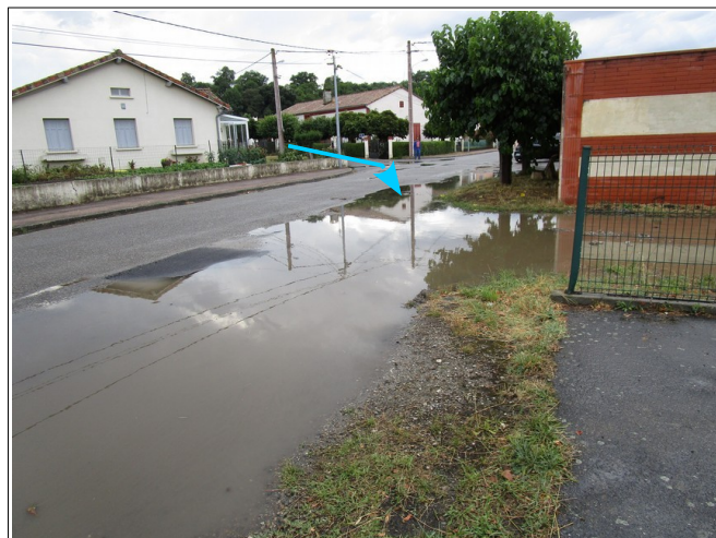
Figure 3.40: avenue de la Gare partiellement inondée à la suite d'une forte pluie de courte durée. L'eau provenait en grande partie de la rue Fount-Marsal située en arrière plan.
