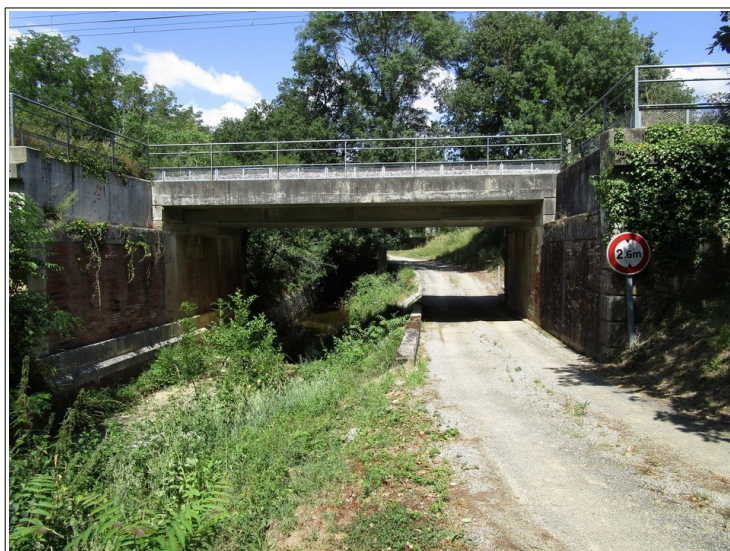
Figure 3.26: pont SNCF et chemin inondable de la ferme de la Miremonde.
