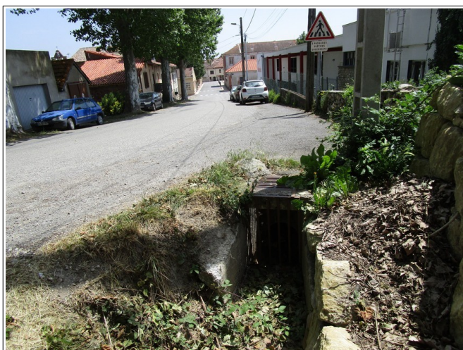
Figure 3.37: RD 14 et fossé routier pouvant drainer des écoulements jusqu'au bourg (secteur des écoles).
