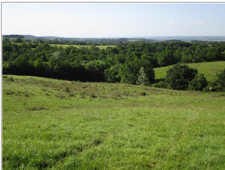
Figure 3.48: fort fluage sur un terrain du lieu-dit Chiquel ; on notera les déformations de la surface du sol.
