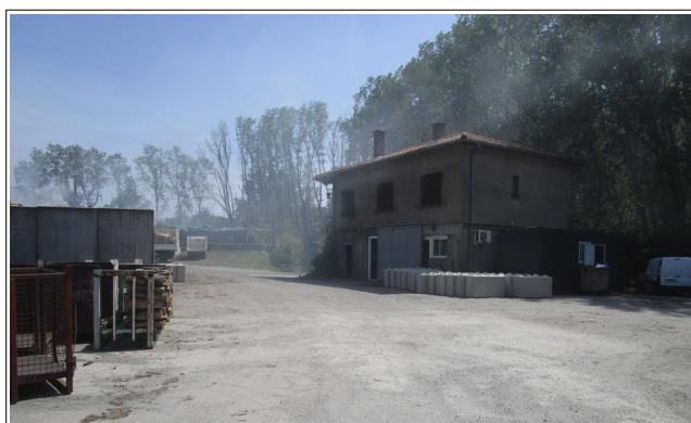
Figure 3.4: site de la charbonnière ; le sommet du merlon encerclant la propriété atteint le premier étage du bâtiment, ce qui permet de juger les hauteurs d'eau.
