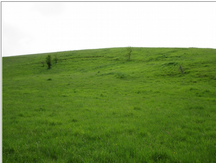
Figure 3.42: glissement de terrain en rive droite de la combe du ruisseau de Pauliac.
