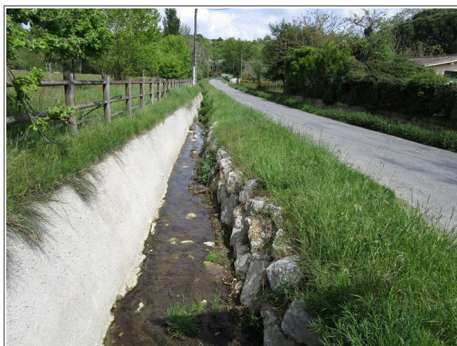
Figure 3.36: fossé parallèle à la RD 436 (route du Château) pouvant évacuer une partie des ruissellements du quartier de la Sarraillère.
