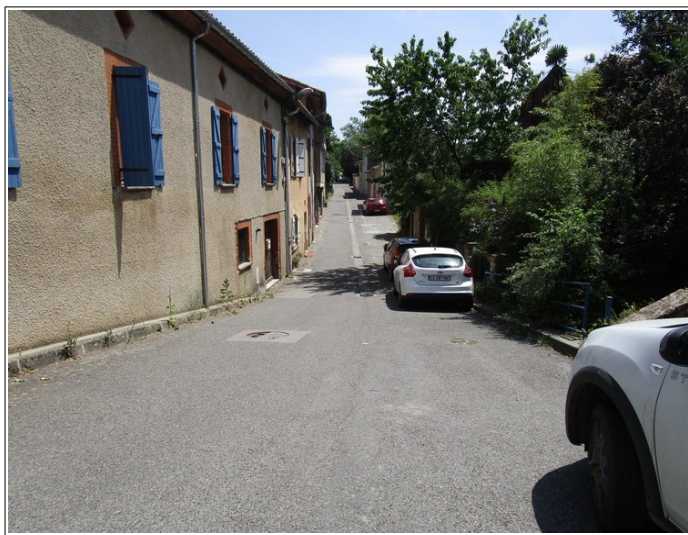
Figure 3.6: rue de la Croix-Blanche en rive droite de l'Ariège, à l'amont du pont de la RD14.
