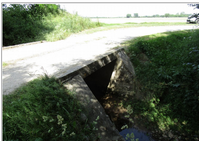
Figure 3.29: pont du chemin de la ferme de l'Hôpital au débouché de la vallée de L'Aure de Canté.
