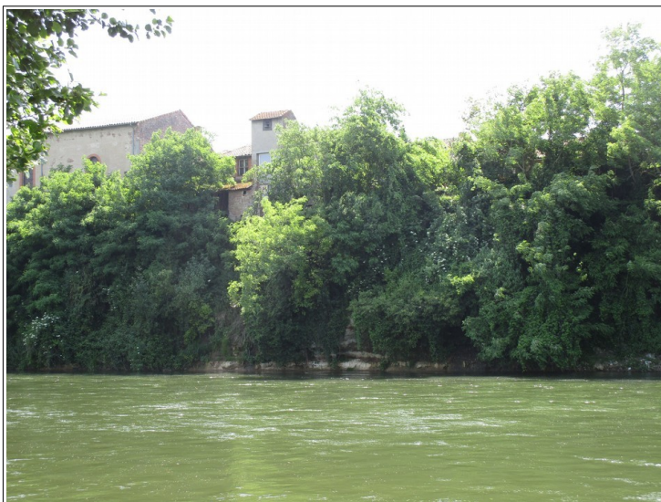
Figure 3.9: rive gauche de l'Ariège au droit du bourg ancien soumise à l'érosion.
