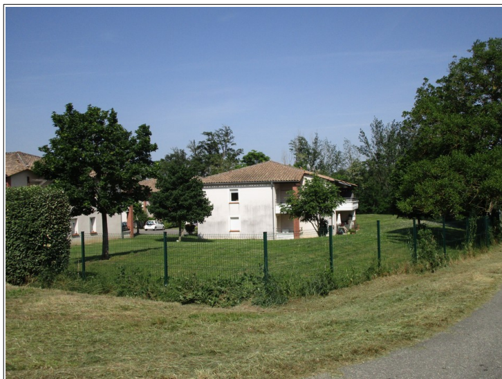
Figure 3.11: bâtiments d'une résidence potentiellement inondables au niveau de la rue Louis Pasteur.
