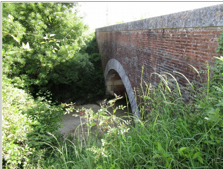
Figure 3.16: franchissement de la voie ferrée par le Crieu.
