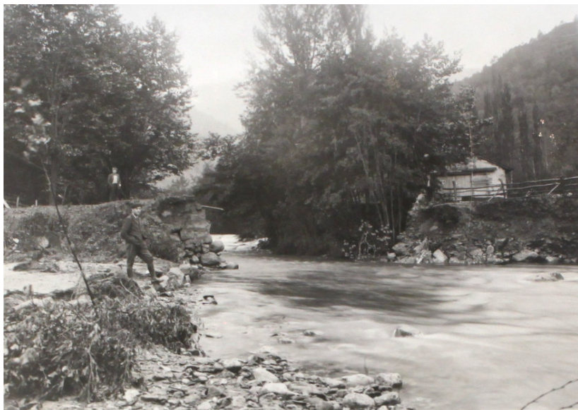
Source : Mairie 1937 – Ce que fut le pont de Seuillac
