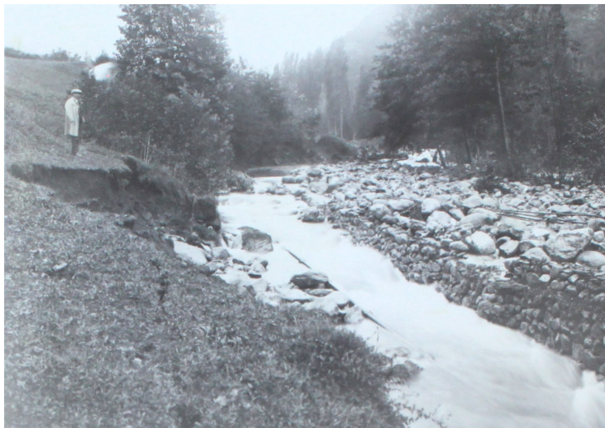
Source : Déclaration des dégâts par la commune (AD 09 -7M15) La route emportée – les canalisations des fontaines apparaissent
