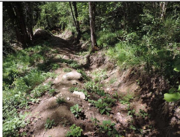
Ruisseau de la Chapelle St Nicolas - Curage du lit et dépôt en berges des matériaux - Drain de collecte des débordements vers le lit
