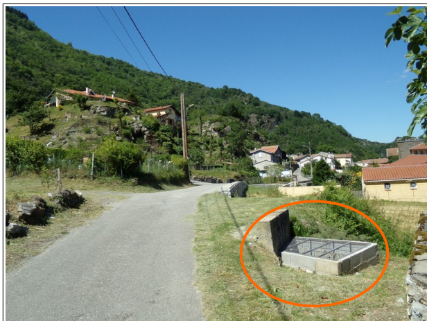
Figure 3.24: franchissement du chemin Communal par le canal de dérivation (ouvrage au premier plan) et de la combe naturelle du Quié-Roux.
