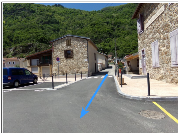
Figure 3.22: Place de l'Ecole dans le prolongement du chemin du Château d'eau, par lequel peuvent se propager les débordements.
