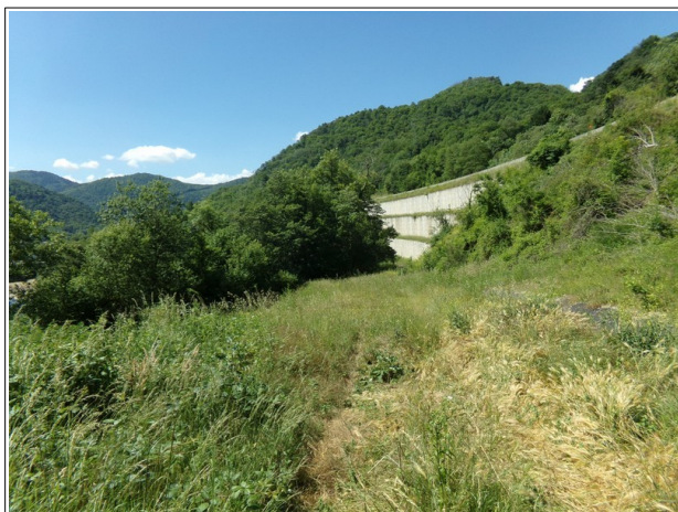
Figure 3.42: tronçon en remblai de la N 20.
