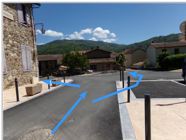
Figure 3.23: au niveau de la place de l'Ecole, les écoulements peuvent se partager entre les rues et traverser des propriétés.
