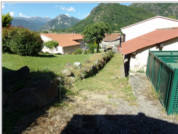
Figure 3.11: mur en pierres parallèle à la RD61 pouvant correspondre à une ancienne protection torrentielle.
