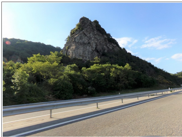
Figure 3.50: falaise des Rochers du Barri dominant la N20 (secteur équipé de filets pare-blocs).
