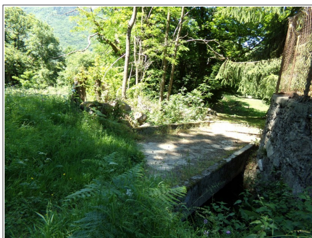
Figure 3.14: franchissement du chemin de la Nougardède par le ruisseau de Rouy (risque de débordement en rive droite).
