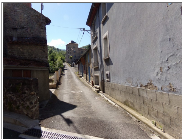
Figure 3.10: chemin du Château par lequel les débordements peuvent se propager jusqu'à la place Jean Jaurès (vue depuis l'aval).
