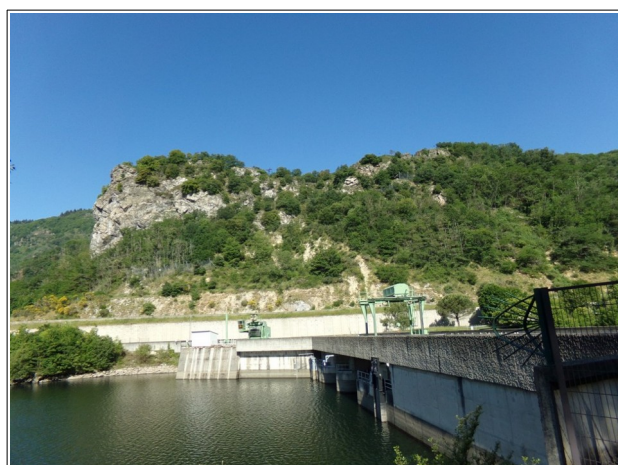
Figure 3.1: Barrage EDF de Garrabet construit à l'entrée d'une gorge.
