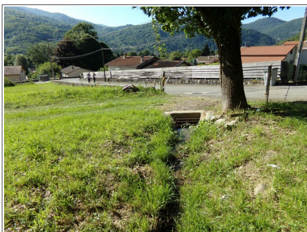
Figure 3.30: busage du ruisseau à la hauteur du chemin des Seignaux.
