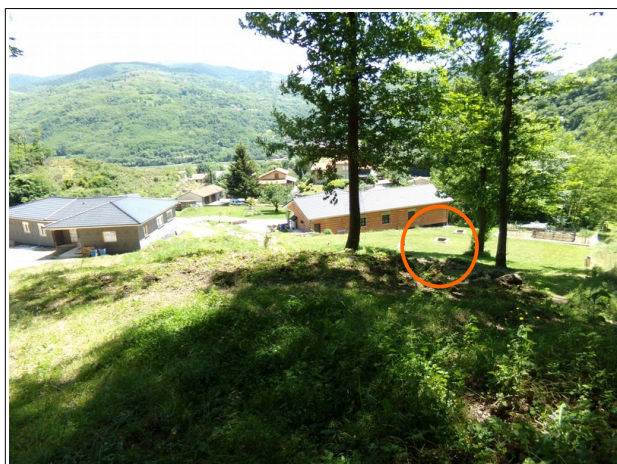
Figure 3.20: le canal de dérivation du ruisseau de Quié-Roux longe la maison de droite. Il est couvert à ce niveau avec de petites ouvertures.
