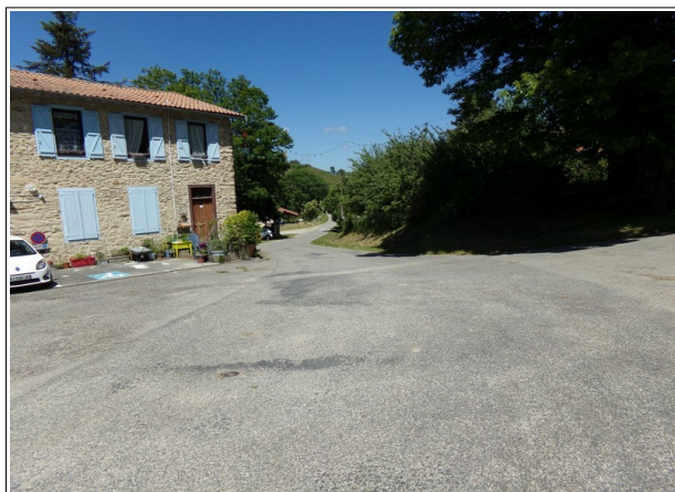
Figure 3.33: RD 61 par laquelle les écoulements de la combe peuvent se propager. La maison à gauche de la photo est potentiellement exposée.
