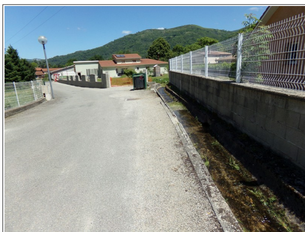
Figure 3.17: vue du chenal du ruisseau parallèle au chemin du Communal (tronçon de section très étroite à ce niveau).
