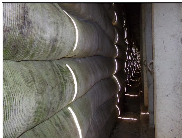
Figure 3.43: remblai de la N 20.
