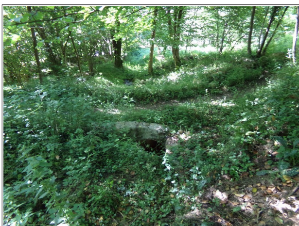
Figure 3.28: ponceau de franchissement du sentier des Jesses.
