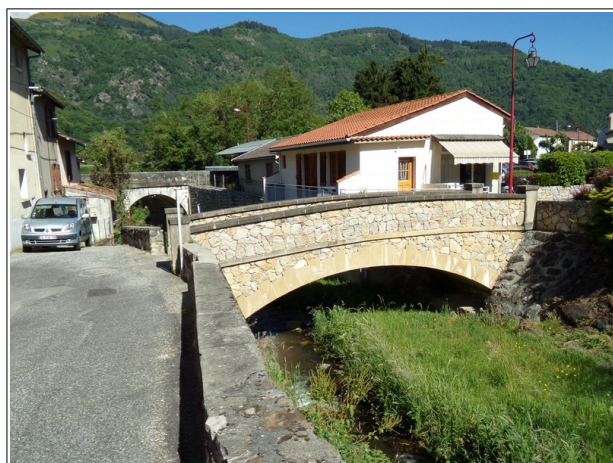
Figure 3.12: pont relativement encombré par des dépôts solides au niveau de la place Jean-Jaurès.
