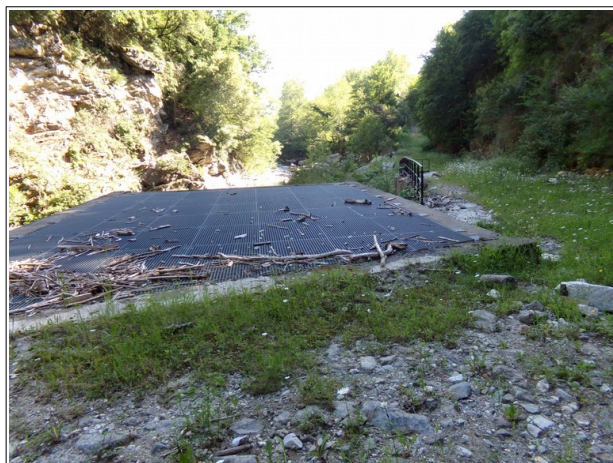
Figure 3.4: laisses de crue de décembre 2019 à l'aval du barrage de Garrabet.
