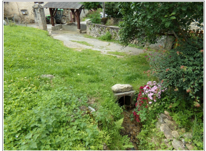
Figure 3.11: busage du ruisseau d'Autère dans la traversée du hameau d'Astien.
