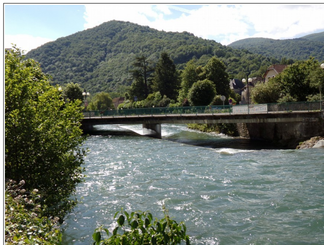
Figure 3.6: pont de la RD 618 vu depuis l'amont ; on notera son ouverture réduite par l'aménagement du seuil servant à la prise d'eau d'un canal.
