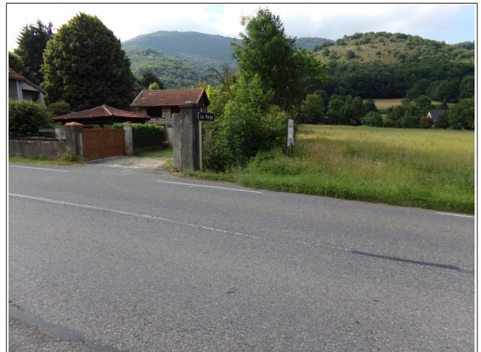
Figure 3.28: franchissement de la RD 618 par le ravin de Barrat (vue depuis l'aval).
