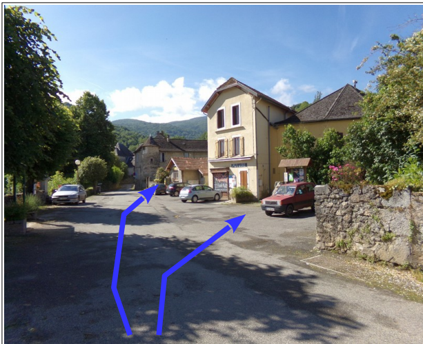
Figure 3.7: le Lez peut atteindre la rue de la Poste puis se propager jusqu'à la place de l'Eglise.
