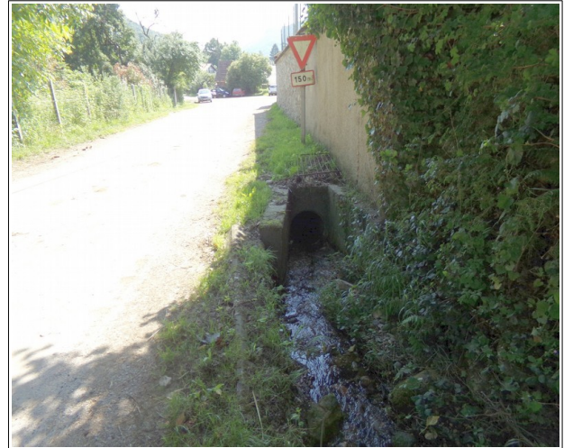
Figure 3.20: busage du fossé de la route Saint-Michel à l'approche de la place du Cimetière.
