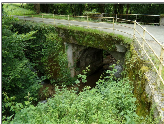
Figure 3.14: pont de la route d'Astien au lieu-dit Autich.
