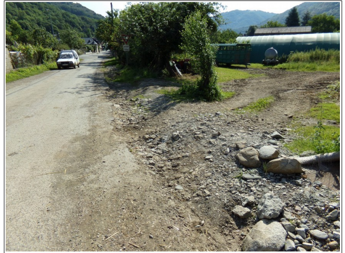
Figure 3.22: les débordements peuvent emprunter la route Saint-Michel en direction de la RD 618. On distingue des traces d'érosion de la crue de mai 2018.
