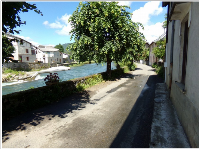
Figure 3.5: rive gauche inondable du Lez à l'amont du pont de la RD618 ; le cours d'eau peut déborder sur le quai Vignau et en direction des habitations.
