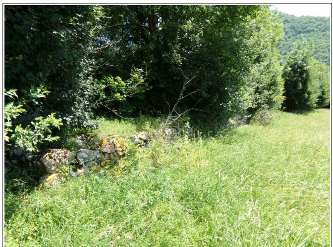
Figure 3.26: endiguement très ancien du ravin de Barrat.
