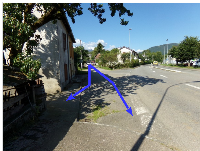
Figure 3.24: embranchement entre la route Saint-Michel et la RD 618. L'eau provenant de la route Saint-Michel se propage sur la RD 618 et ses bas-cotés.
