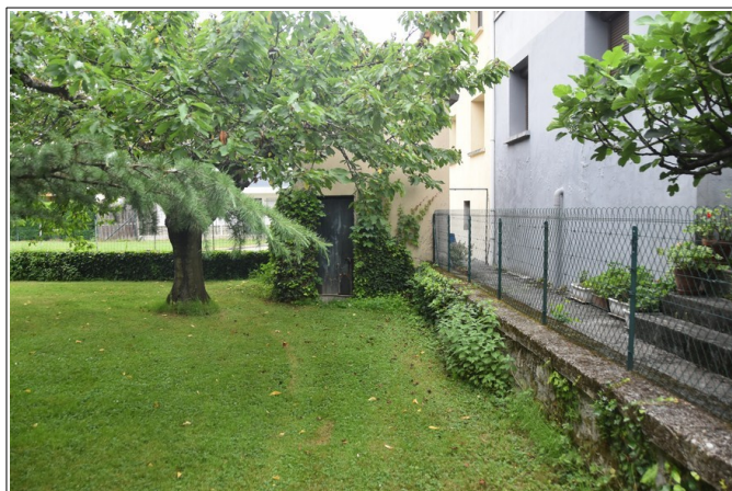
Figure 3.26: ruisseau de Saint-Jean couvert (trottoir sur la droite de la photo) et terrain inondable à la hauteur du 41, avenue du Général de Gaulle (RD 117).
