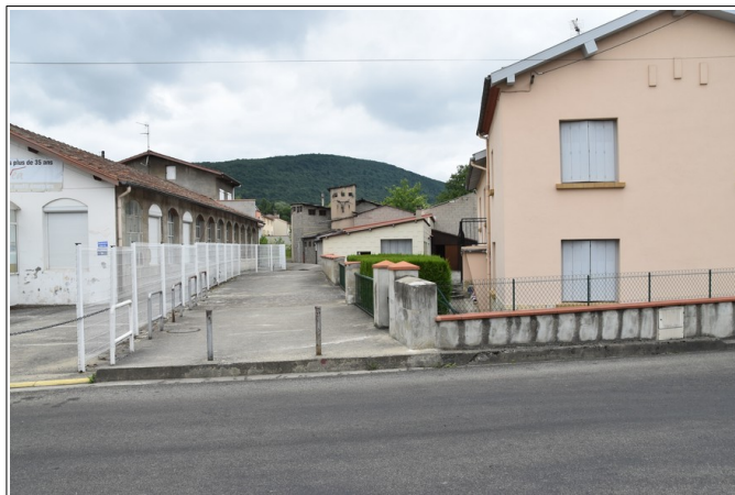
Figure 3.31: ruisseau de Raissac couvert et propriété en travers du lit majeur au niveau de la rue du Maréchal Joffre (sur la droite de la photo) avec un point bas au niveau de la maison.
