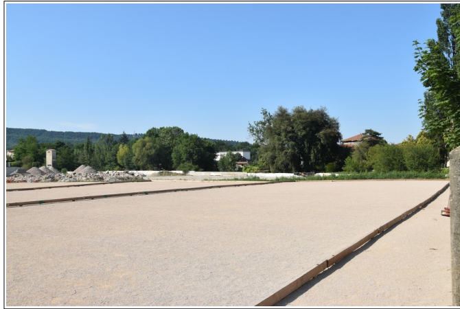
Figure 3.15: site de l'ancienne usine Roudière inondable.
