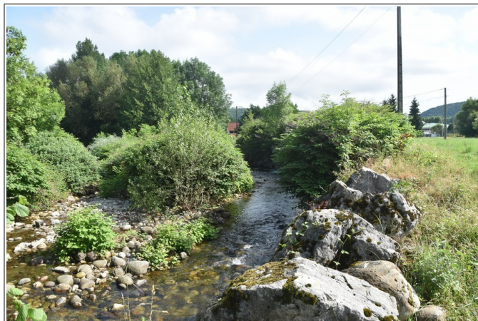
Figure 3.7: vue du méandre du lycée. On notera la faible profondeur du lit et l'enrochement ancien de la rive droite.
