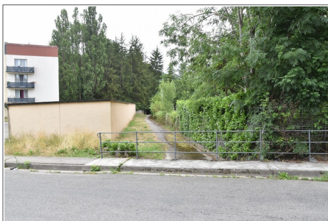
Figure 3.30: couverture du ruisseau de Raissac à partir de la rue du Maréchal Leclerc.
