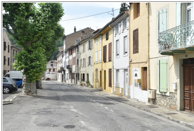
Figure 3.23: rue Saint-Jean sous laquelle s'écoule le Tort avant de s'en écarter (à gauche des platanes).
