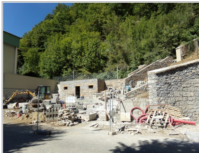
Figure 3.52: affleurements rocheux en rive gauche de la cluse de Lavelanet (masqués par la végétation). A l'amont de la construction en cours, on distingue le filet posé suite à un événement de chutes de blocs
