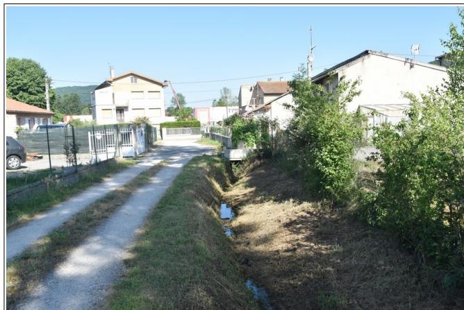
Figure 3.25: ruisseau de Saint-Jean avant son busage sous l'entreprise "Tout Faire Matériaux".
