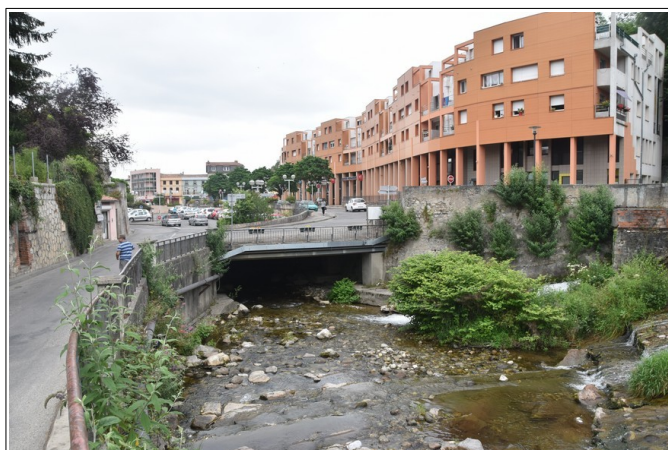
Figure 3.12: entrée de l'ouvrage de couverture du Touyre à l'amont de la place de l'Europe (visible en arrière plan).
