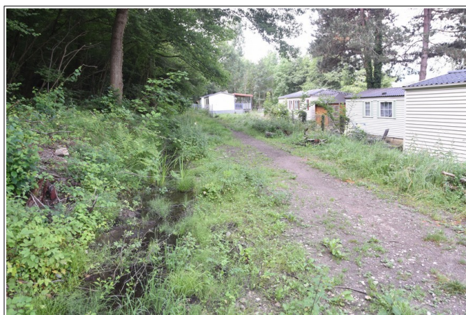
Figure 3.42: fossé de la Prairie de Cabobès à la hauteur du camping de Pré-Cathare.
