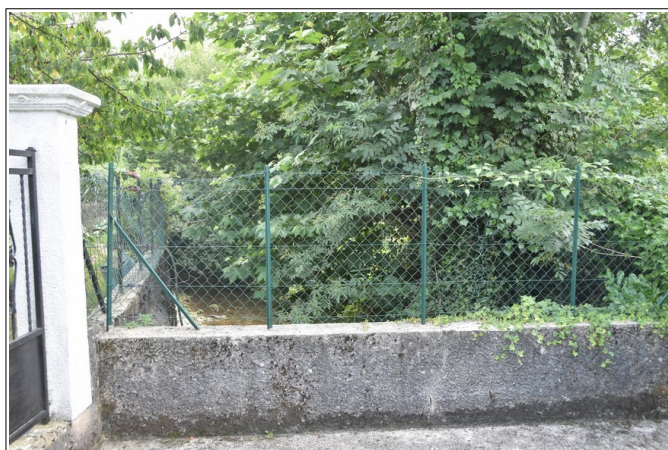
Figure 3.18: début de l'ouvrage de couverture du Tort au niveau de la Cité Voltaire.
