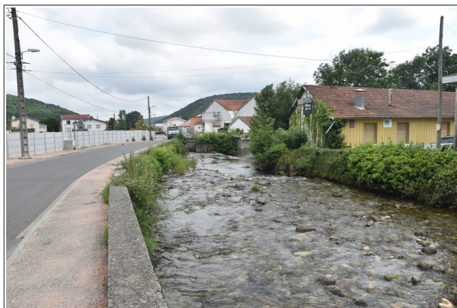
Figure 3.9: le Touyre au droit du stade Paul Bergère; Des débordements sont possibles en rive gauche sur la route. La lame d'eau peut ensuite se diriger vers la RD117.
