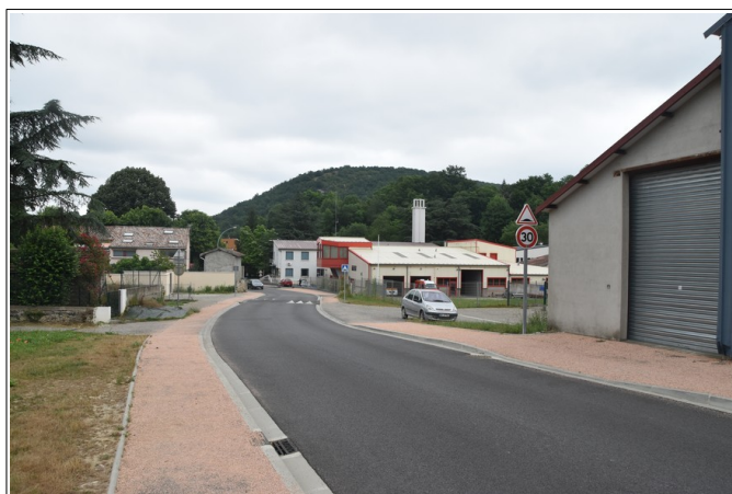
Figure 3.11: rue du Quille et caserne des pompiers en partie inondables.
