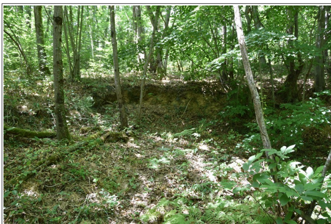
Figure 3.47: décrochement de terrain attribuable à un arrachement sur le versant sud de la colline de Gaillasse, au droit de l'ancienne station d'épuration.
