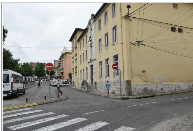
Figure 3.32: place Henri Dunant où aboutissent les débordements du ruisseau de Raissac.
