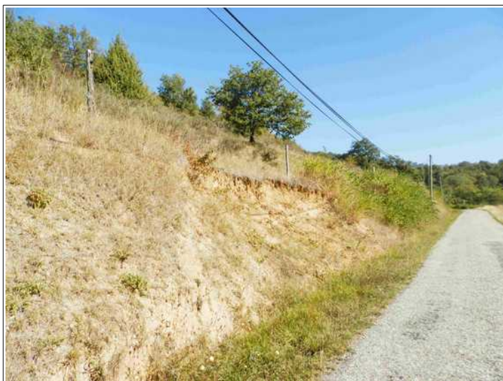
Figure III.13: glissement de talus le long de la RD713.
