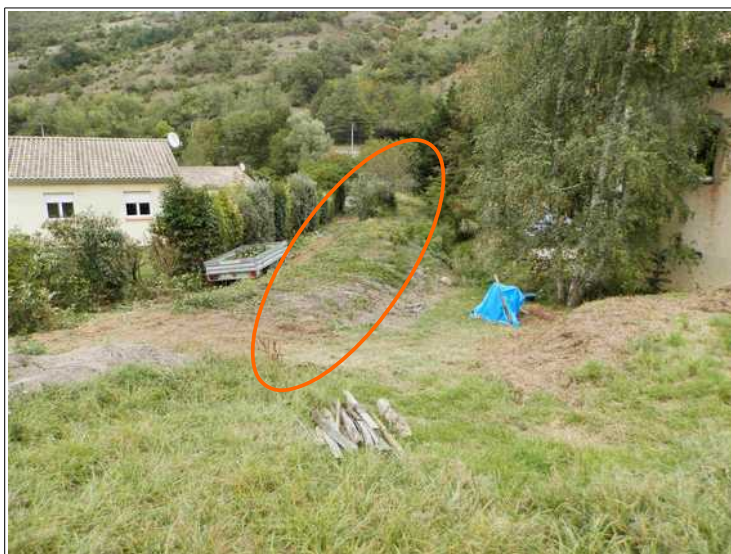
Figure III.11: digue en rive gauche du ruisseau édifée pour la construction de trois pavillons.
