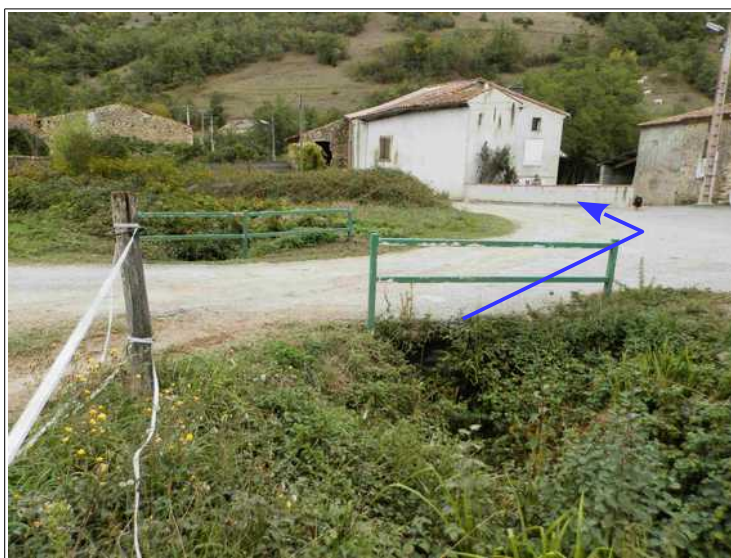
Figure III.10: débouché du ruisseau dans le hameau de Pény. En débordant au niveau du pont, le cours d'eau se dirige préférentiellement en direction de la maison en arrière plan.
