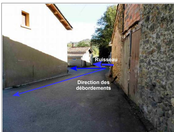
Figure III.6: le ruisseau de Mouny au débouché de sa combe. Le cours d'eau longe une propriété vers laquelle il peut déborder.
