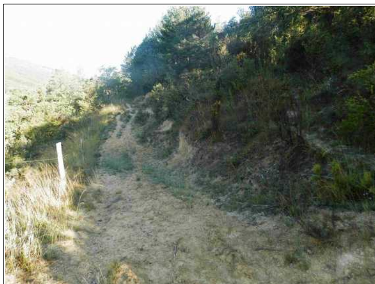
Figure III. 14: Versant rive droite du Méridic au droit du hameau de Dieulafé. On notera en arrière plan l'aspect déformé du terrain, souligné par le chemin. Cette zone, probablement humide par intermittence, présente des signes de fluage.
