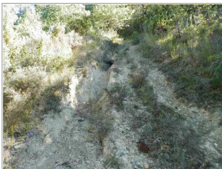
Figure III.12: exemple de ravinement d'un axe hydraulique du lieu-dit La Tuilerie. Ici, les écoulements sont drainés par un chemin rural, puis ils se dispersent sur un terrain à l'amont de la RD13.
