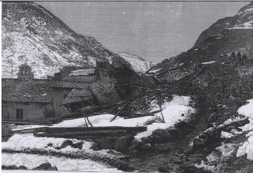
Toit apporté d'une distance de 40 m par l'ouragan sur les débris d'une autre maison
