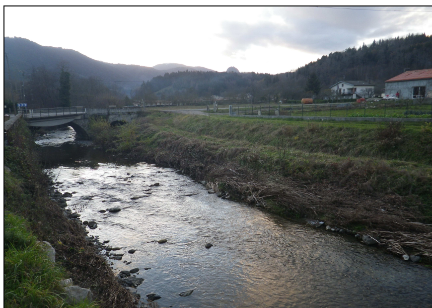
Figure 10: L'Hers depuis la RD 5, à l'aval du village de Fougax, après les épisodes pluvieux de novembre 2011 (source: Agerin)
