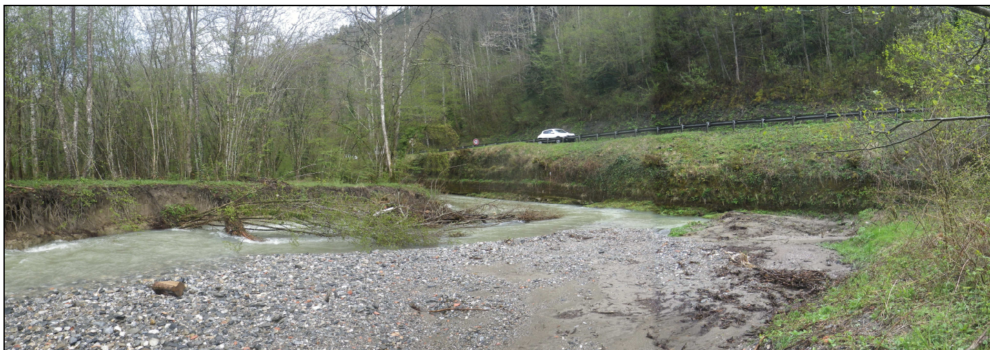
Figure 13: L'Hers depuis la RD 5, à l'aval du village de Fougax, après les épisodes pluvieux de novembre 2011 (source: Agerin)
