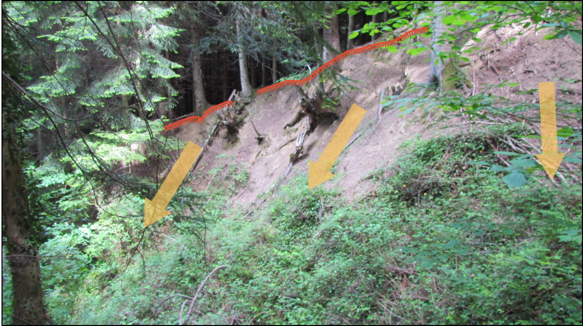
Figure 27: Zones de glissement au niveau d'une ravine fonctionnant par intermittence à l'aval du hameau de l'Espine (source: Agerin)
