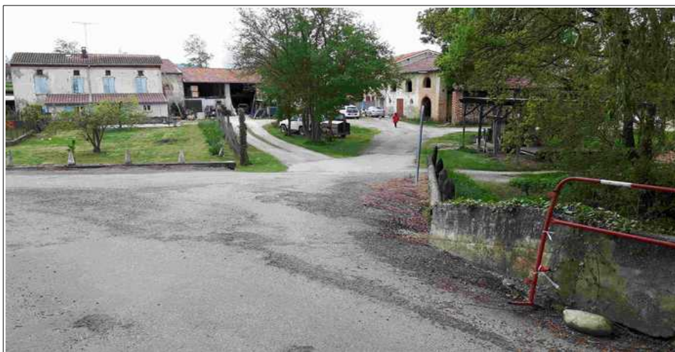
Figure III.5: rive gauche du Crieu inondable à l'aval du chemin du Coussa.
