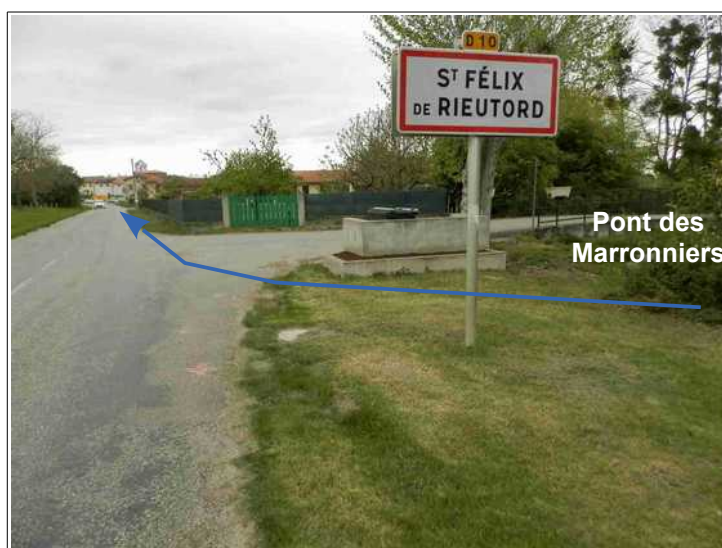
Figure III.4: amont du village. En cas de débordement au pont des Marronniers, le Crieu peut se déverser en rive gauche sur la RD10.
