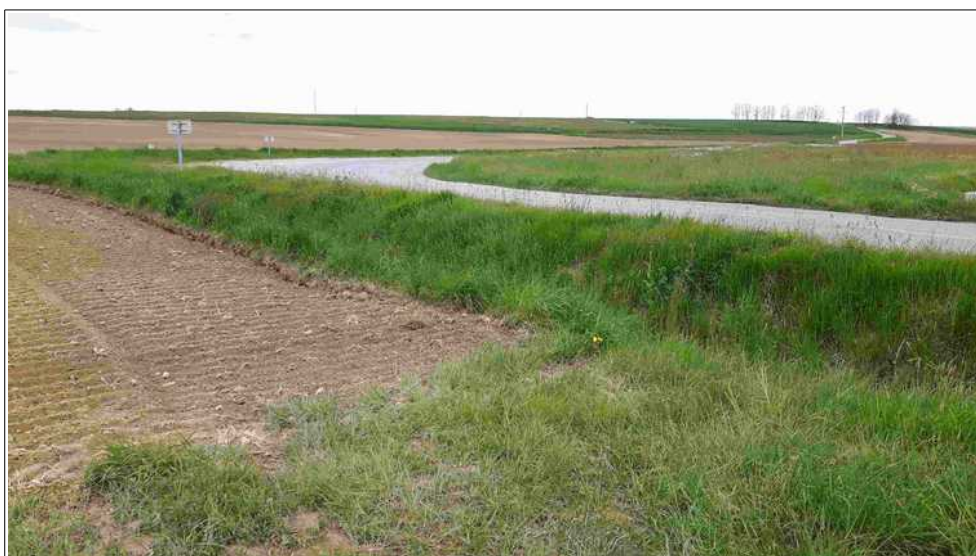
Figure III.6: La RD10 et ses abords inondables dans la plaine de Saint-Félix-de-Rieutord.
