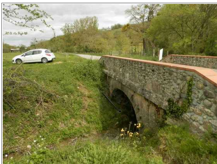
Figure III.7: pont de la RD10.
