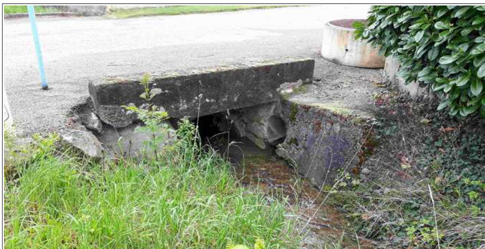
Figure III.12: franchissement de la RD410 par le ruisseau. Une voûte fait rapidement suite au dalot.
