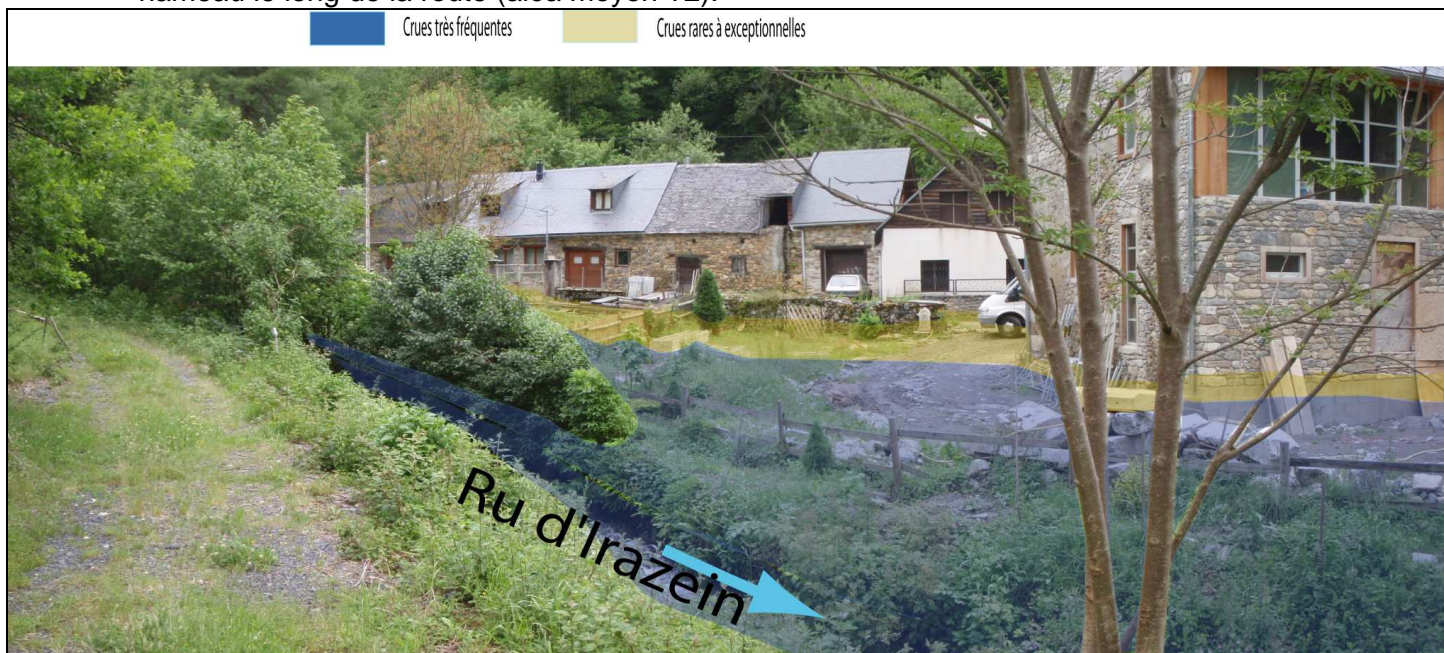
Figure 12 : Débordements à Marbre (source: Agerin)
