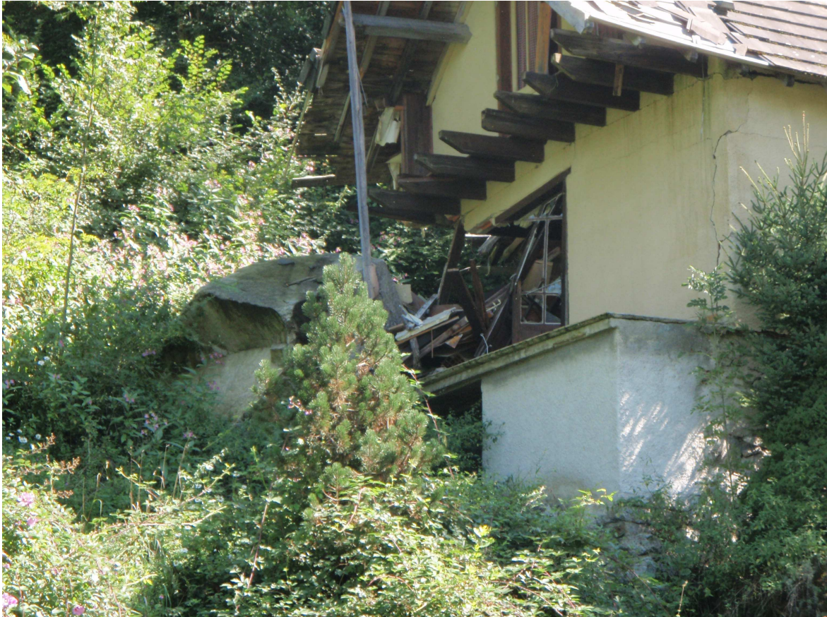
Habitation touchée par un bloc fin 2008 dans le secteur du Redounet (Source AGERIN)
