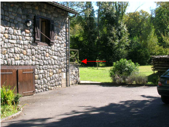
Photographie 9 : Le Moulin inondé en 1995. L'eau arrivait au niveau de la terrasse (Source : Agerin)
