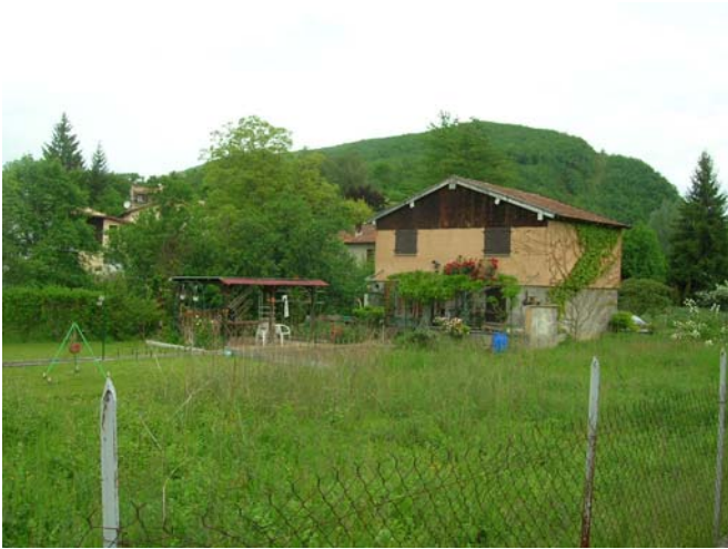
Photographies 1 : Grange détruite en 1972 ; lors de la crue du ruisseau de Bénaix
