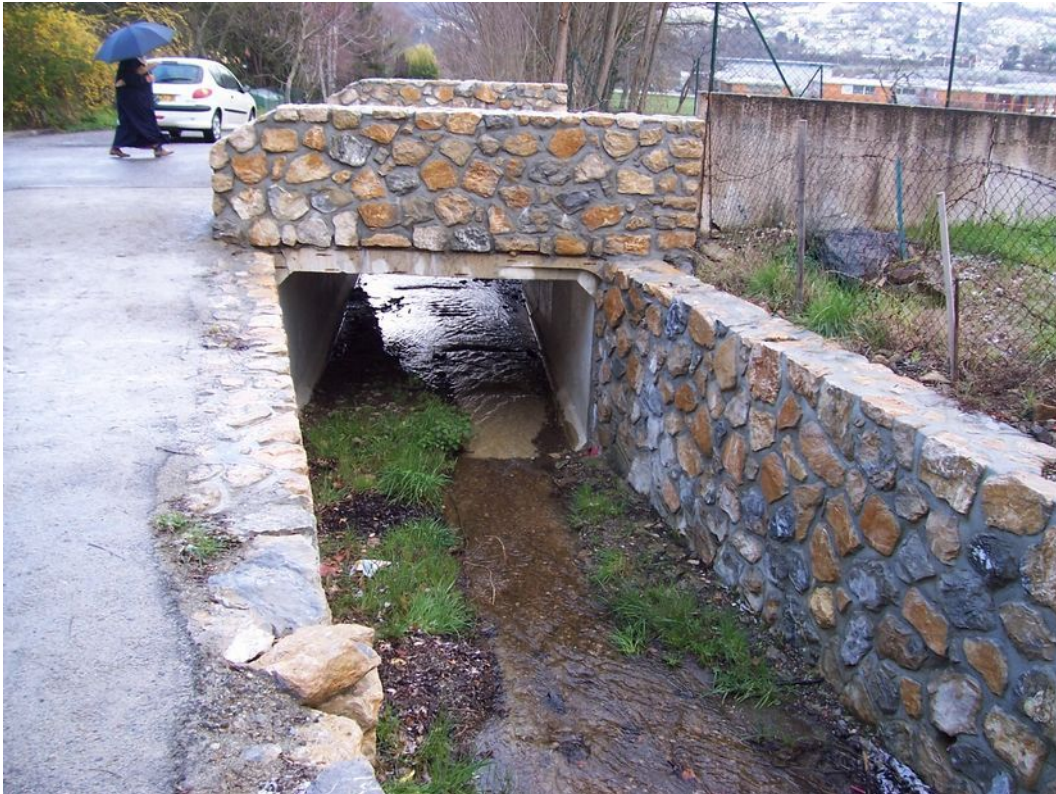
Illustration 5: Pont du ruisseau du Garriac situé sous la VC
