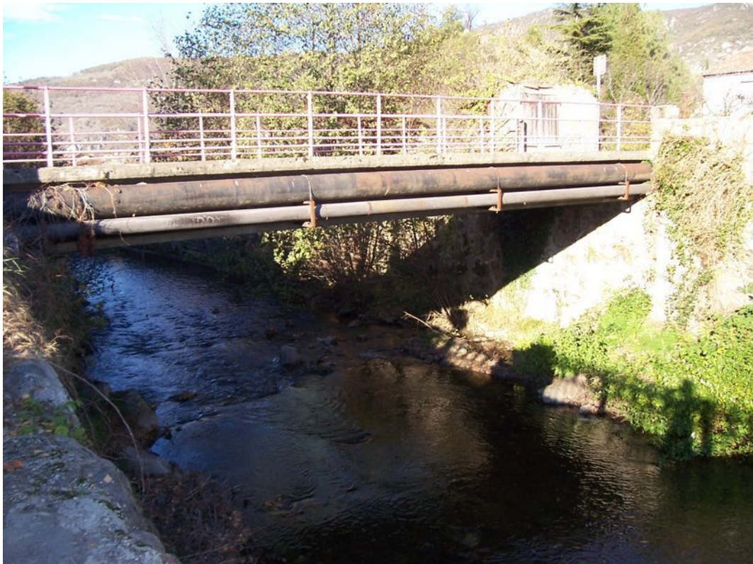
Illustration 6: Pont de la rue de La Loume.
