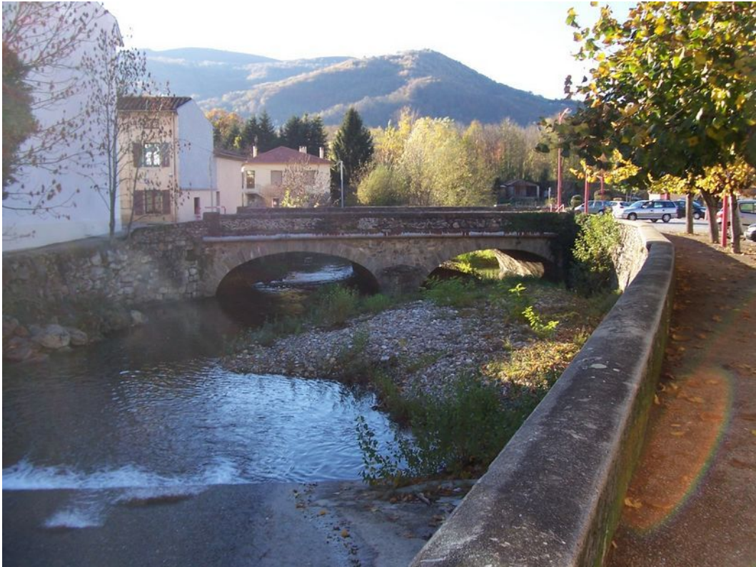
Illustration 4: Pont sous la RD 117, l'arche de droite est obstruée par le dépôt solide du torrent.
