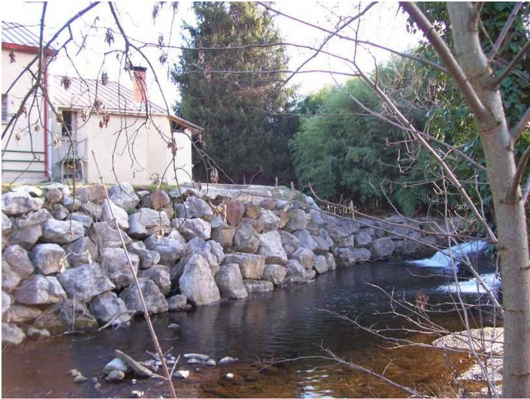
Illustration 4: Remblai conséquent du local technique
