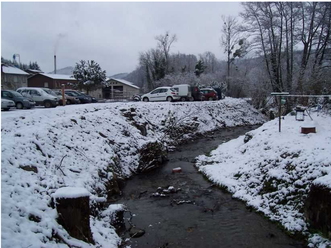
Illustration 5: ruisseau de Labat à la hauteur du hameau de Langlade illustrant le conséquent remblai du parking de la Scierie
