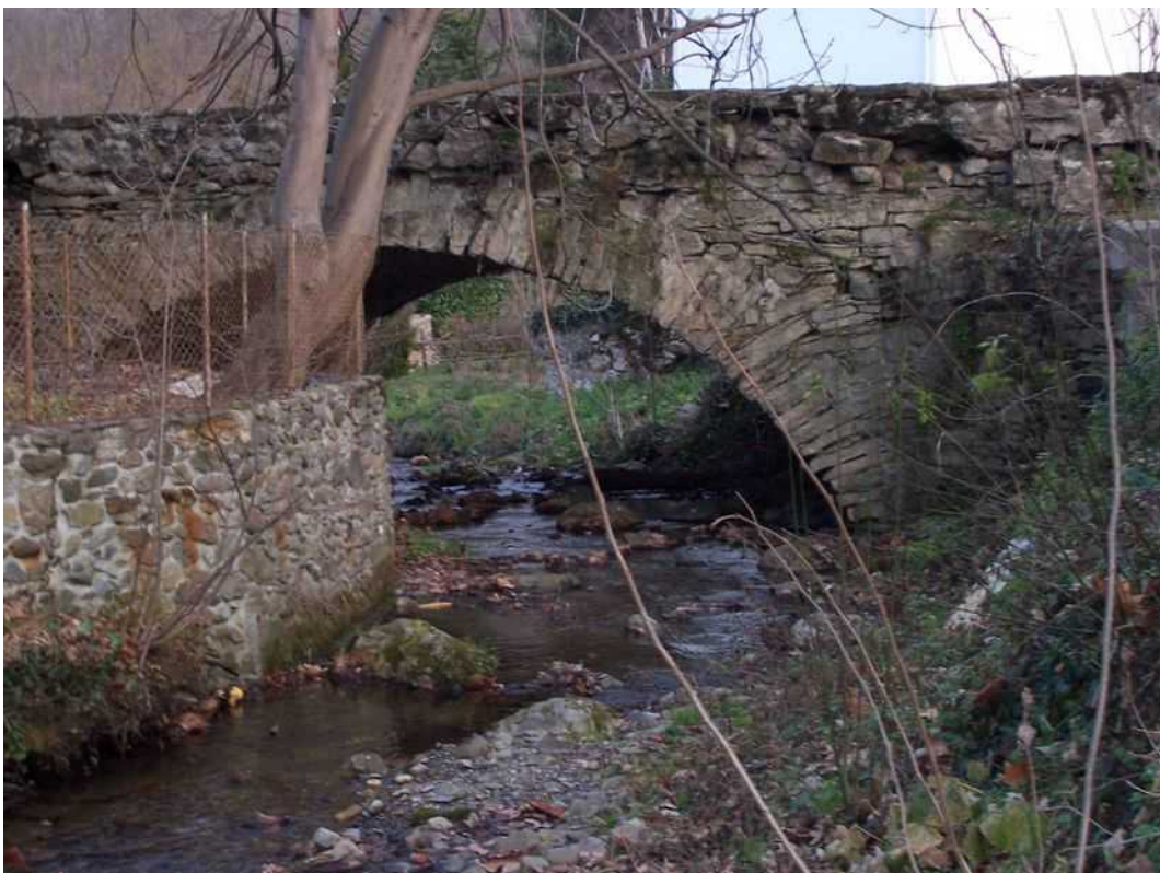
Illustration 7: Ancien pont sous la rue principale du bourg (le mur situé rive gauche entrave une partie de la section de l'ouvrage)
