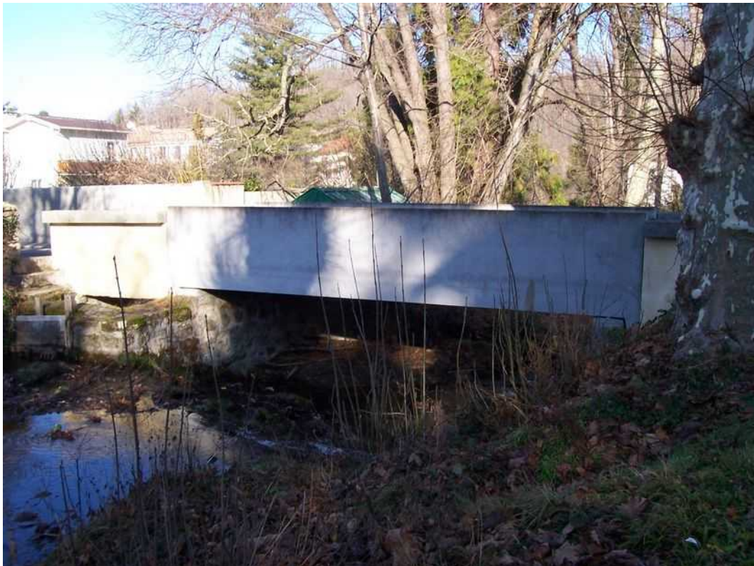
Illustration 6: Pont de la rue de la Tuilerie
