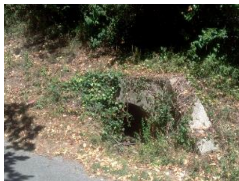
Aval de l'ouvrage
