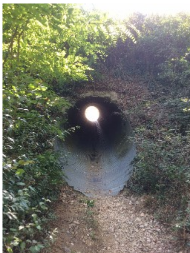
Amont de l'ouvrage
