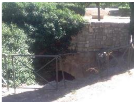
Amont de l'ouvrage
