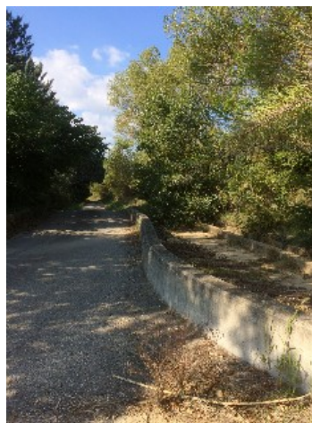
Lit mineur chenalisé pour ramener les écoulements vers le ruisseau du Petit Pont d'Arc
