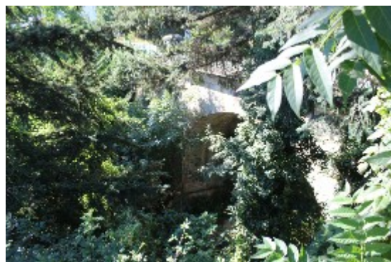
Vue de l'ouvrage MER07
