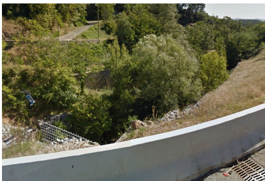
Vue du ruisseau de Mercouare vers l'aval depuis le pont de la RN.102 (source Google Earth)
