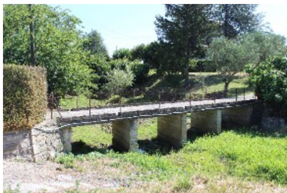
Amont de l'ouvrage STL05
