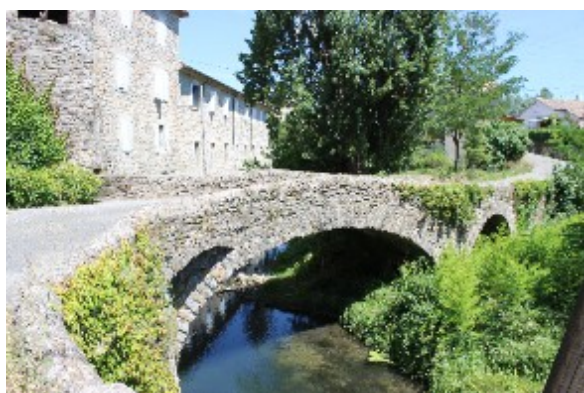
Vue de l'ouvrage AUN04
