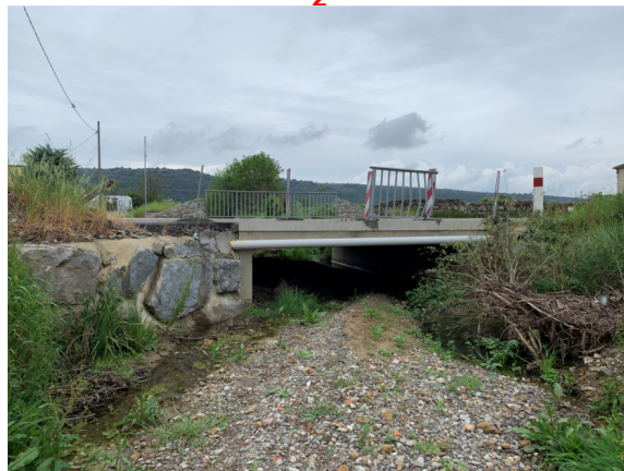
Amont de l'ouvrage STL01
