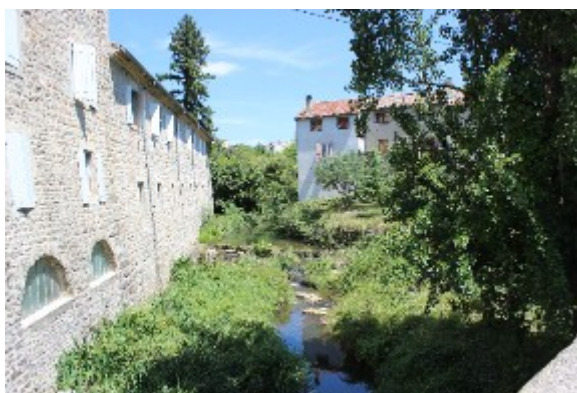
Aval des seuils AUN05
