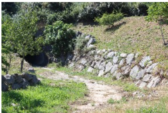
Amont de l'ouvrage STL04 – lit entretenu
