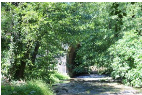
Aval de l'ouvrage AUN02 – Lit mineur entretenu
