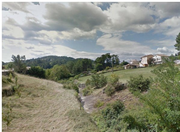
Vue vers l'aval du pont de la RD.578b sur le Sandron (commune d'Ucel– source Google Earth)
