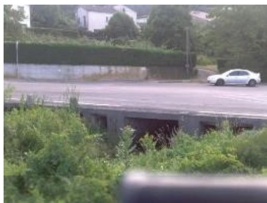
Ouvrage de la RD435 (MER03)
