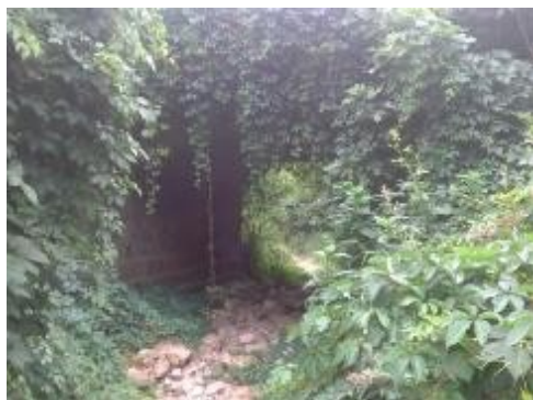
Amont de l'ouvrage JUM02
