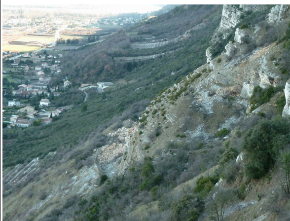
Vue sur le versant : falaise à l'amont - couverture d'éboulis de pente dans le versant
