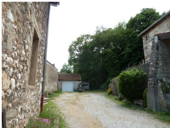
Habitation de gauche en limite de P3G2 sous : zone de propagation des blocs
