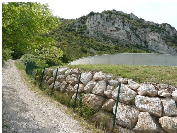
Illustration 14: Réservoir d'eau composé de deux cuves en zone AOC
