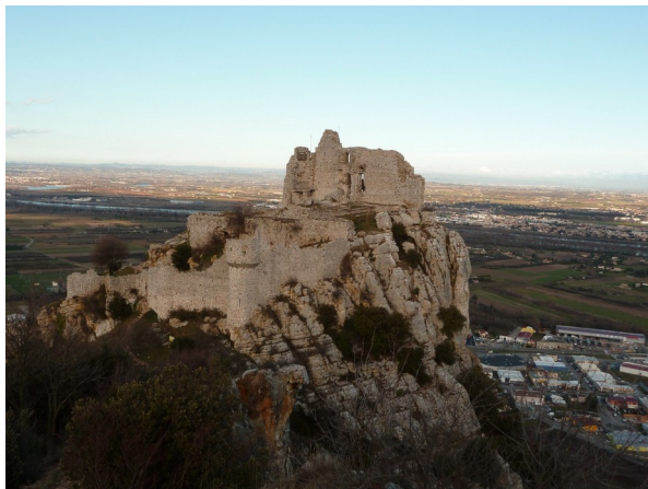
Partie amont du secteur 2 : falaise calcaire fracturée
