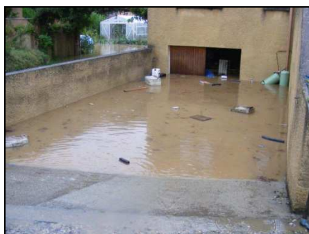
Garage inondé dans le vieux village
