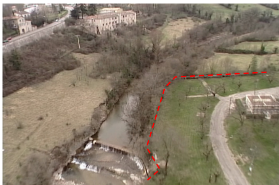
Digue de protection du camping
