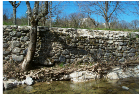
Détail de la digue
