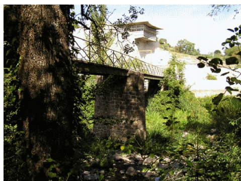
Passerelle de la STEP
