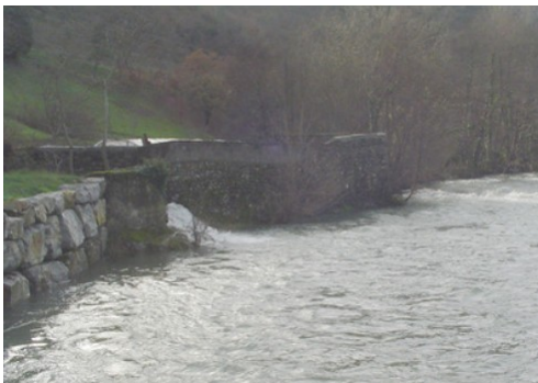
Digue de Chabrier – vue côté rivière
