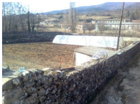
Digue de Chabrier – vue côté terre
