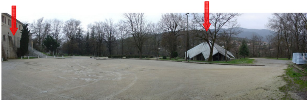
Bâtiments en rive droite touchés par les eaux au droit du moulin Gaucher
