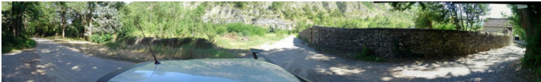
Digue de Tamaris
