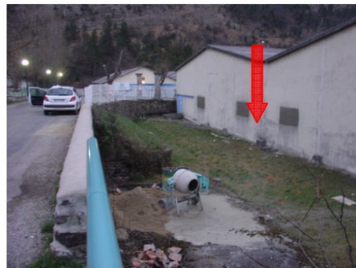
Sous-sol moulinage Chabert
