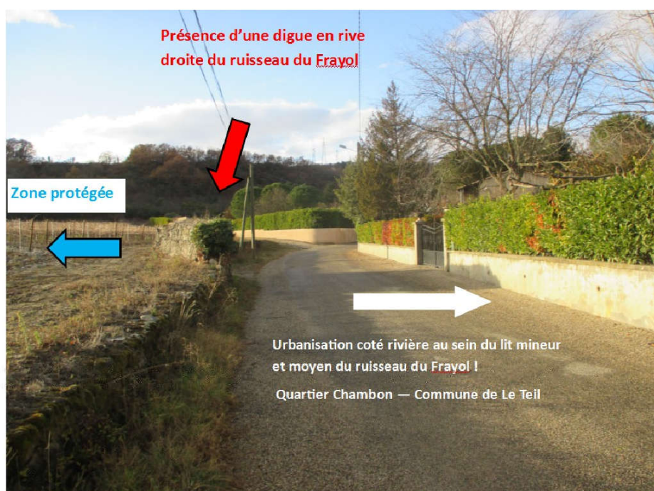
Emprise importante au sein du lit moyen (voirie, habitation) au droit du quartier Chambon – commune de Le Teil – 08 décembre 2017
