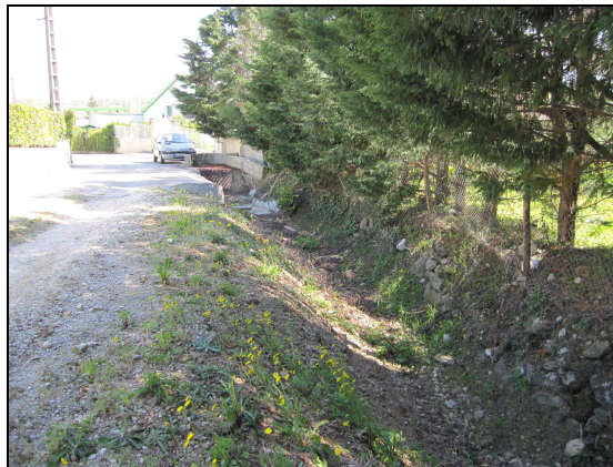
Figure 3-12 : Le Rely juste en amont de son passage en secteur busé
