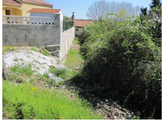
Figure 3-14 : La Souchère à proximité des habitations à l'aval
