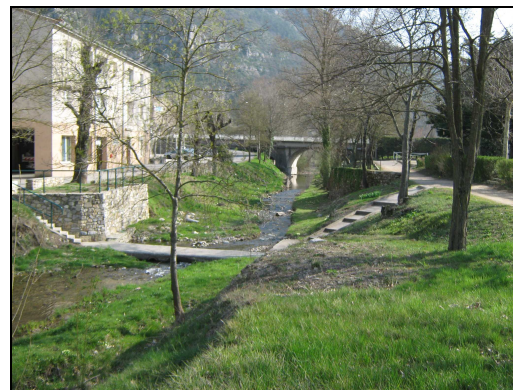
Figure 3-10 : Aval du Chambaud
