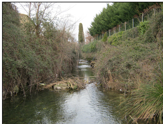
Figure 3-10 : La Sardagne à l'aval dans Bourg-Saint-Andéol
