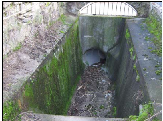
Figure 3-12 : Passage en souterrain à l'entrée dans Champagne
