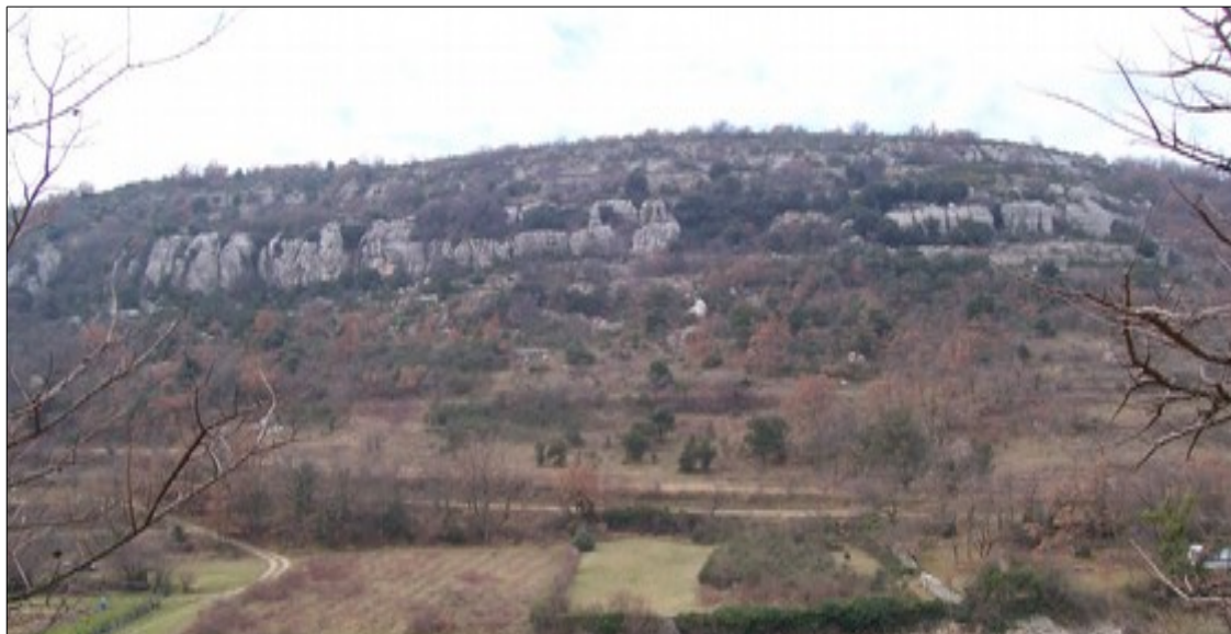
figure 70 : Versant dominant la voie communale n°1, au Nord du hameau des Aliberts
