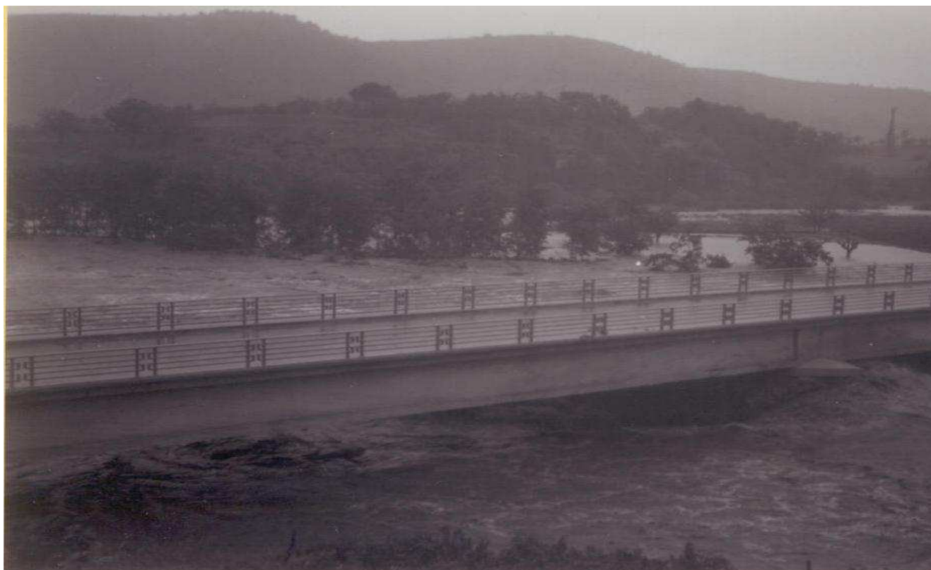
Crue octobre 1958 - aval pont de la Beaume
