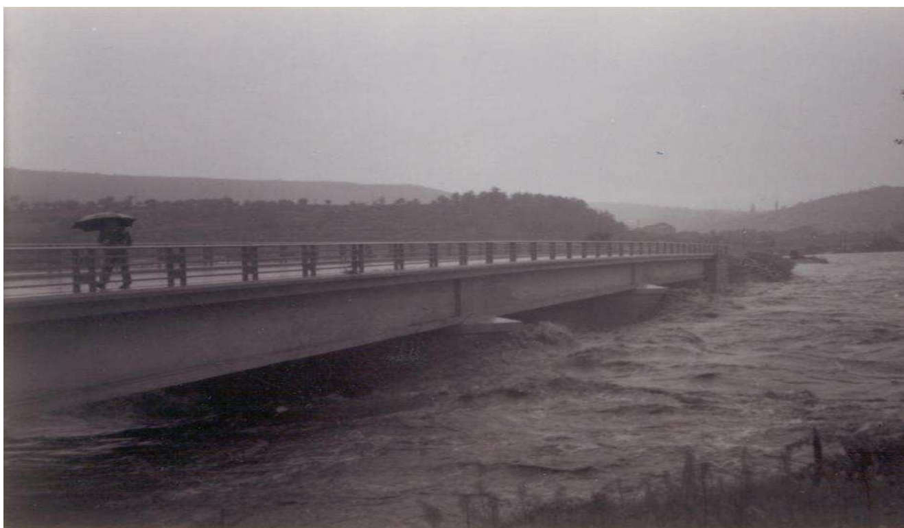
Crue octobre 1958 - amont pont de la Beaume
