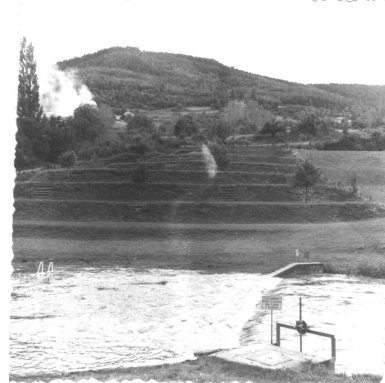
Photo 4 : Vue de l'ouvrage d'entrée
