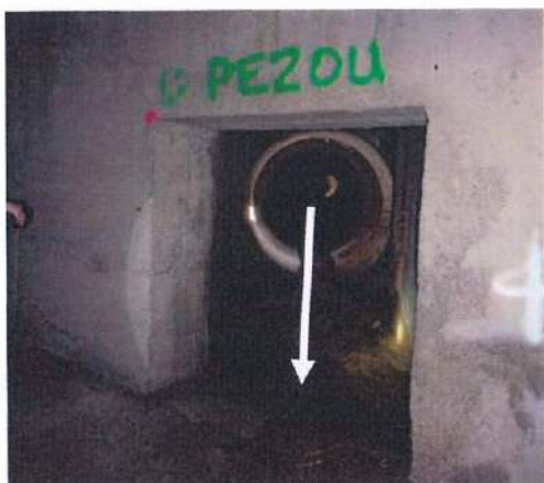
Figure 14 : Photographie de la confluence entre le Pezou et la Foux - Radier dégradé
