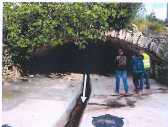
Figure 7 : Photographie de l'ouvrage voûté
