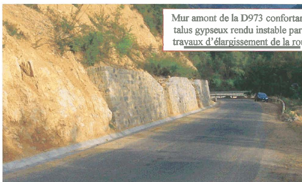
Mur de soutènement du talus amont de la route menant au « Blaquet ».
