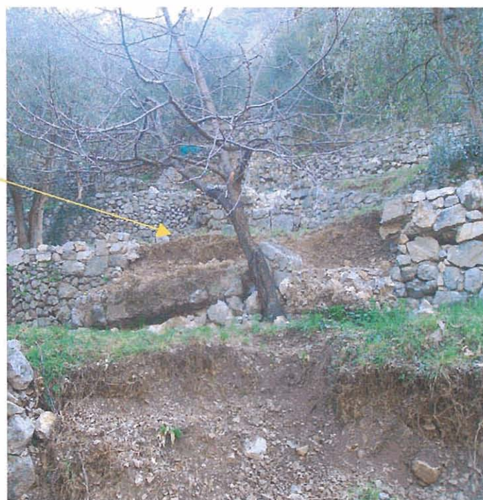
Zoom sur l'impact du bloc au niveau de la troisième planche agricole (en partant de l'aval).
