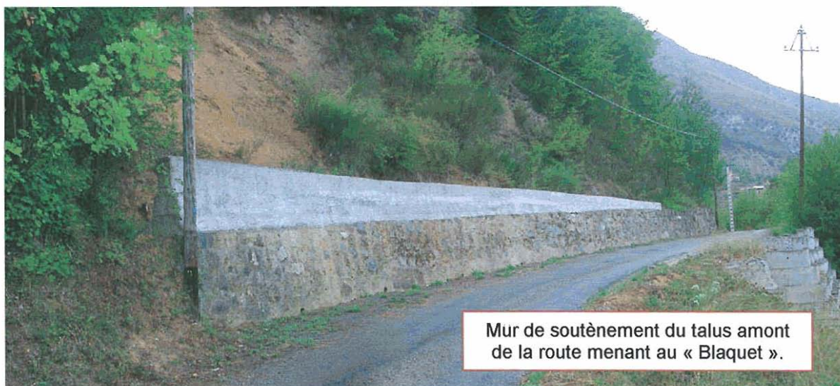
Mur amont de la D973 confortant le talus gypseux rendu instable par les travaux d'élargissement de la route .
