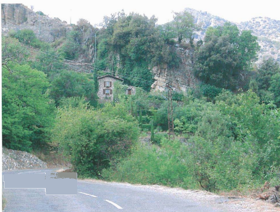
Escarpement rocheux à l'origine de la chute d'un bloc sur le bâtiment.
