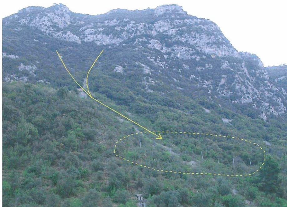
Ci-dessus : Filets de protection contre les chutes de blocs protégeant le hameau du Chaudan et couloir préférentiel Ci-dessous : divers dispositifs de protection bordant la D2565.
