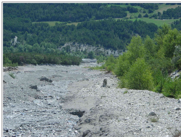
Le Devezet à l'aval de la RD614, on notera la largeur importante du lit mineur. On distingue également sur la droite de la photo la digue RTM en partie masquée par la végétation
