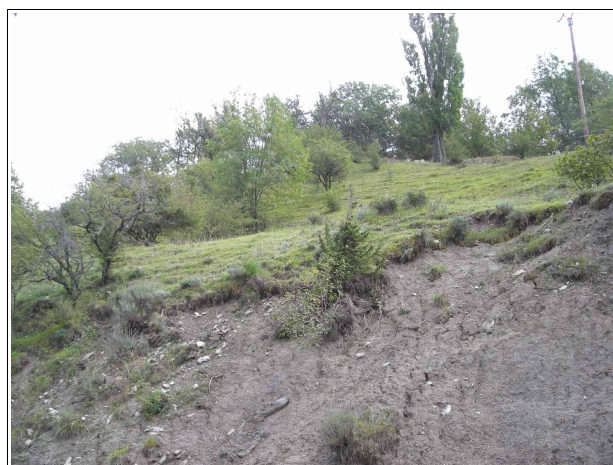
Vue du terrain à l'aval du village, visée depuis la RD93, les lieux présentent un aspect légèrement chaotique caractéristique des mouvements de terrain.
