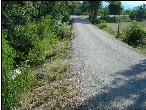
Chemin digue menant au Poustas aménagé en rive gauche du Saint-Pancrace à l'amont de l'ancienne RN94.
