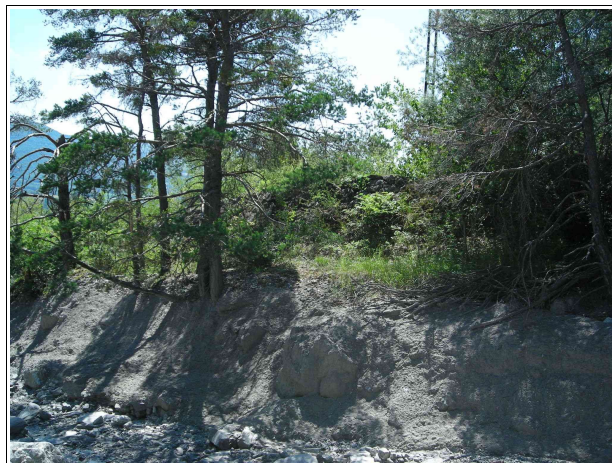
Autre vue du Devezet à l'amont de la RD614, on distingue à l'arrière plan le sommet de la digue érigée au XIXème siècle (photo prise après la crue de juin 2010). On notera le niveau atteint par la crue (trace grise) et la revanche restante qui peut être plus fortement réduite en cas de crue plus conséquente et/ou d'obstruction du lit.
