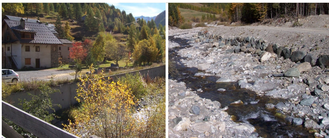
Figure 11: Endiguement béton et enrochements (Alp'Géorisques, 2010).
