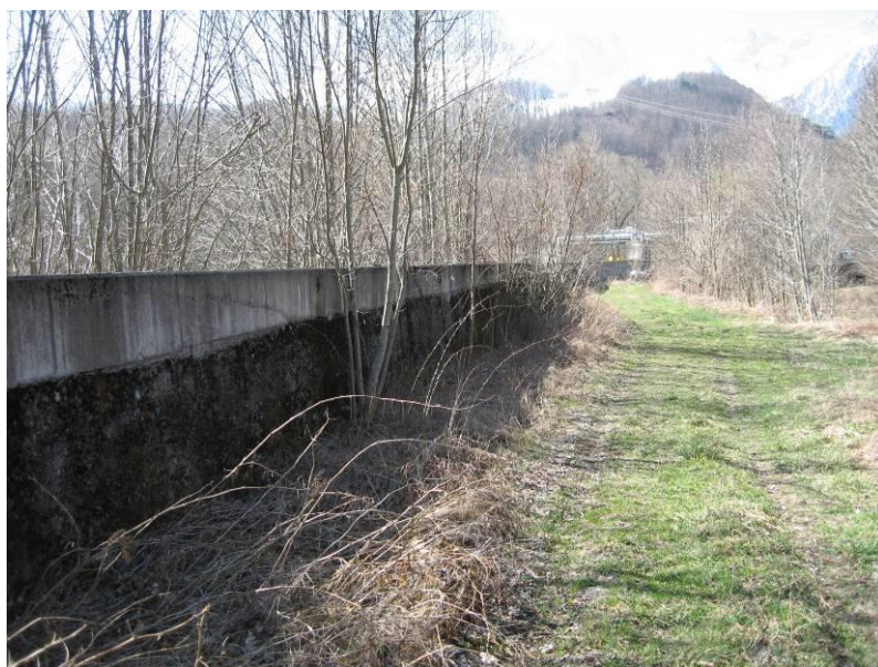
Muret de protection en bordure de la zone de projet d'une nouvelle zone d'activité – ouvrage qui semble en bon état – même hauteur que le talus naturel bordant la Séveraisse
