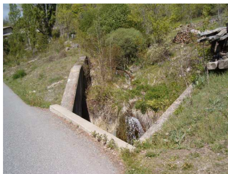
Figure 16 – Ouvrage sur le torrent de Jaimes (Alp'Géorisques)
