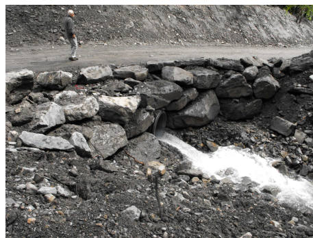
Figure 20 – Torrent de l'Odeyer et buse de franchissement de la route (Alp'Géorisques)
