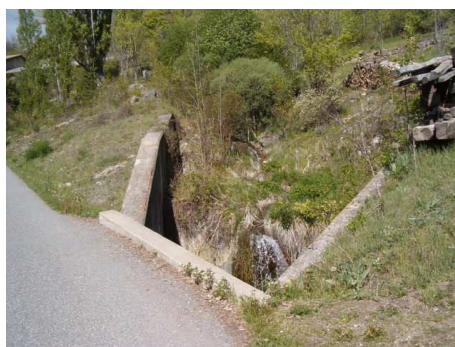
Figure 16 – Ouvrage sur le torrent de Jaimes (Alp'Géorisques)
