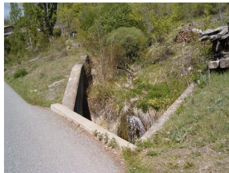
Figure 16 – Ouvrage sur le torrent de Jaimes (Alp'Géorisques)
