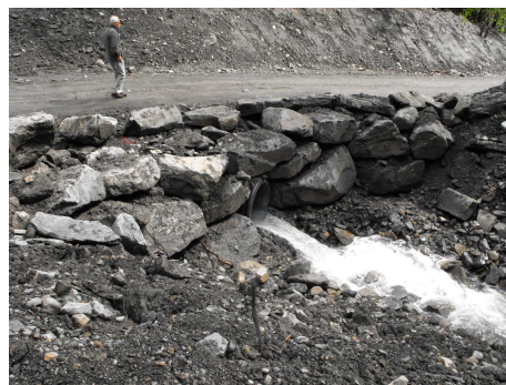
Figure 20 – Torrent de l'Odeyer et buse de franchissement de la route (Alp'Géorisques)
