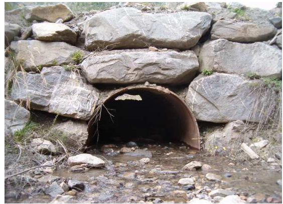
Figure 19 – Buse au franchissement de la route (Alp'Géorisques)
