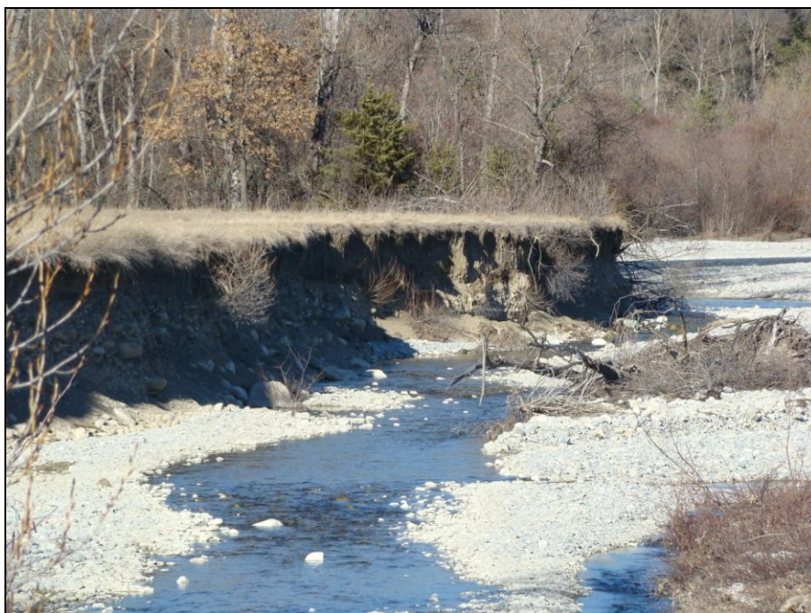
Figure 43 : Erosion de berges le long du Petit Buëch [Source : IMS RN ]
