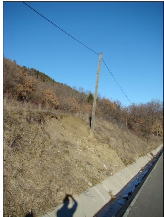
Figure 39 : Glissement dans le secteur de la Baumette. A gauche : chaussée fissurée. A droite : poteau TELECOM incliné et talus instable [Source : IMS RN ]
