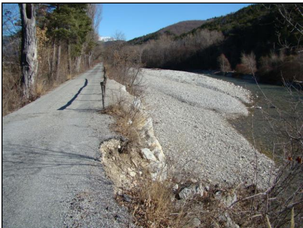
Figure 42 : Digue endommagée le long du Grand Buëch, dans le secteur de la Rabière [Source : IMS RN ]
