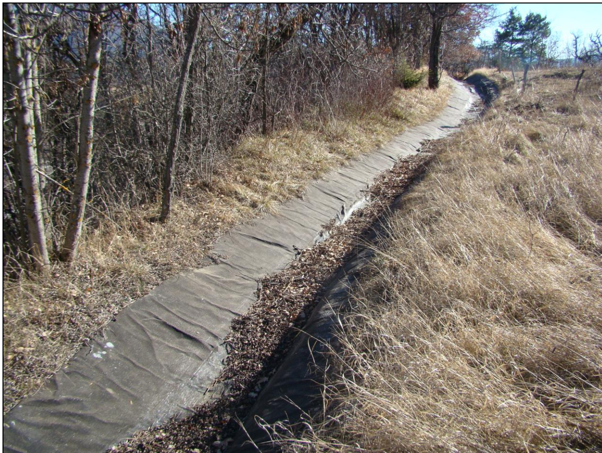
Figure 35 : Travaux de stabilisation du glissement au Sud de Grange Neuve, fossé de drainage [Source : IMS RN ]
