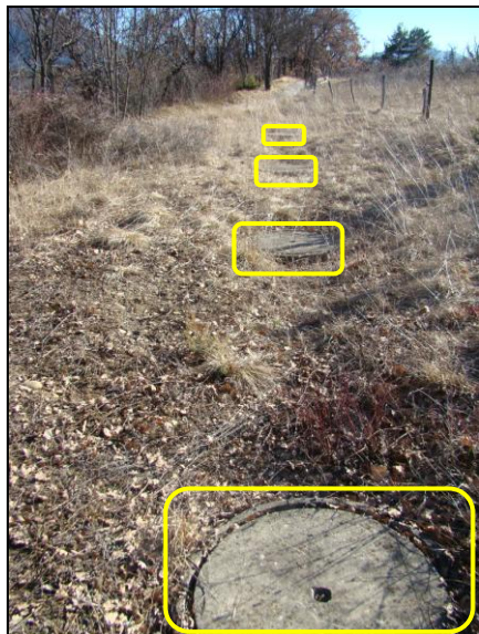
Figure 33 : Travaux de stabilisation du glissement au Sud de Grange Neuve. A gauche : regards de tête des drains verticaux. A droite : vue de l'intérieur d'un regard [Source : IMS RN ]
