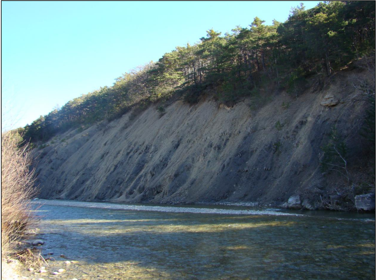
Figure 41 : Erosion de berge le long du Grand Buëch, en amont des ponts de la RD 994a et de la voie ferrée [Source : IMS RN ]
