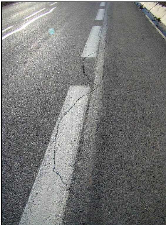
Figure 39 : Glissement dans le secteur de la Baumette. A gauche : chaussée fissurée. A droite : poteau TELECOM incliné et talus instable [Source : IMS RN ]
