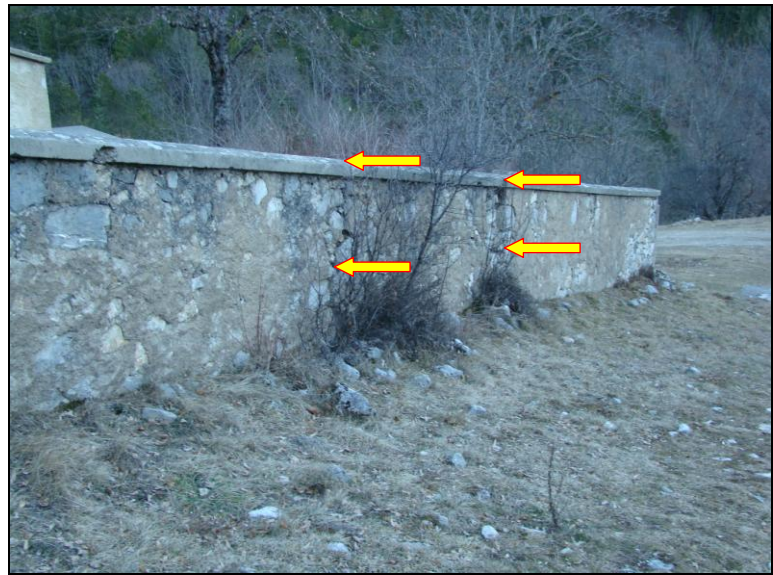
Figure 30 : Murs fissurés (à droite, celui du cimetière) dans le hameau d'Agnielles [Source : IMS RN ]
