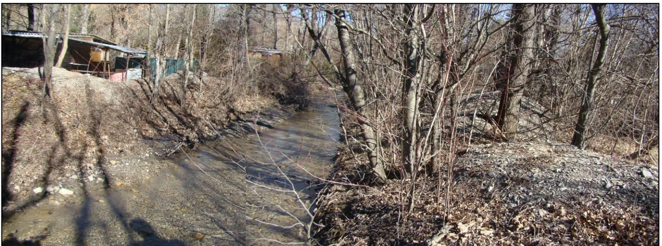
Figure 83 : Torrent de Bellerique traversant le camping de l'Aldrech [Source : IMS RN ]
