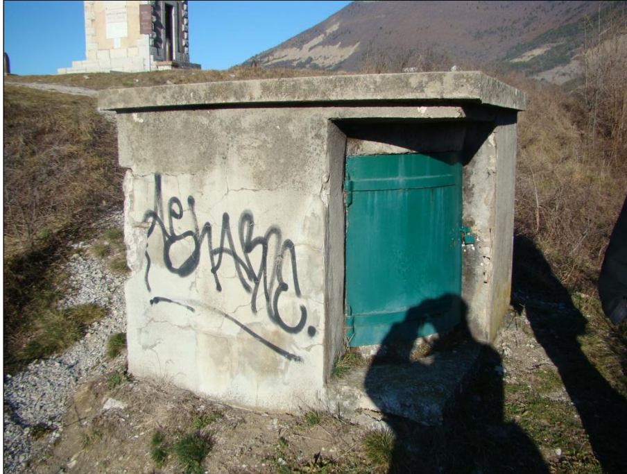
Figure 60 : Ouvrage civil recensé dans la BD-Cavités, au niveau de la butte du Square de Verdun [Source : IMS RN ]
