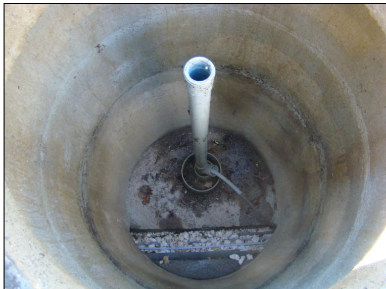
Figure 33 : Travaux de stabilisation du glissement au Sud de Grange Neuve. A gauche : regards de tête des drains verticaux. A droite : vue de l'intérieur d'un regard [Source : IMS RN ]
