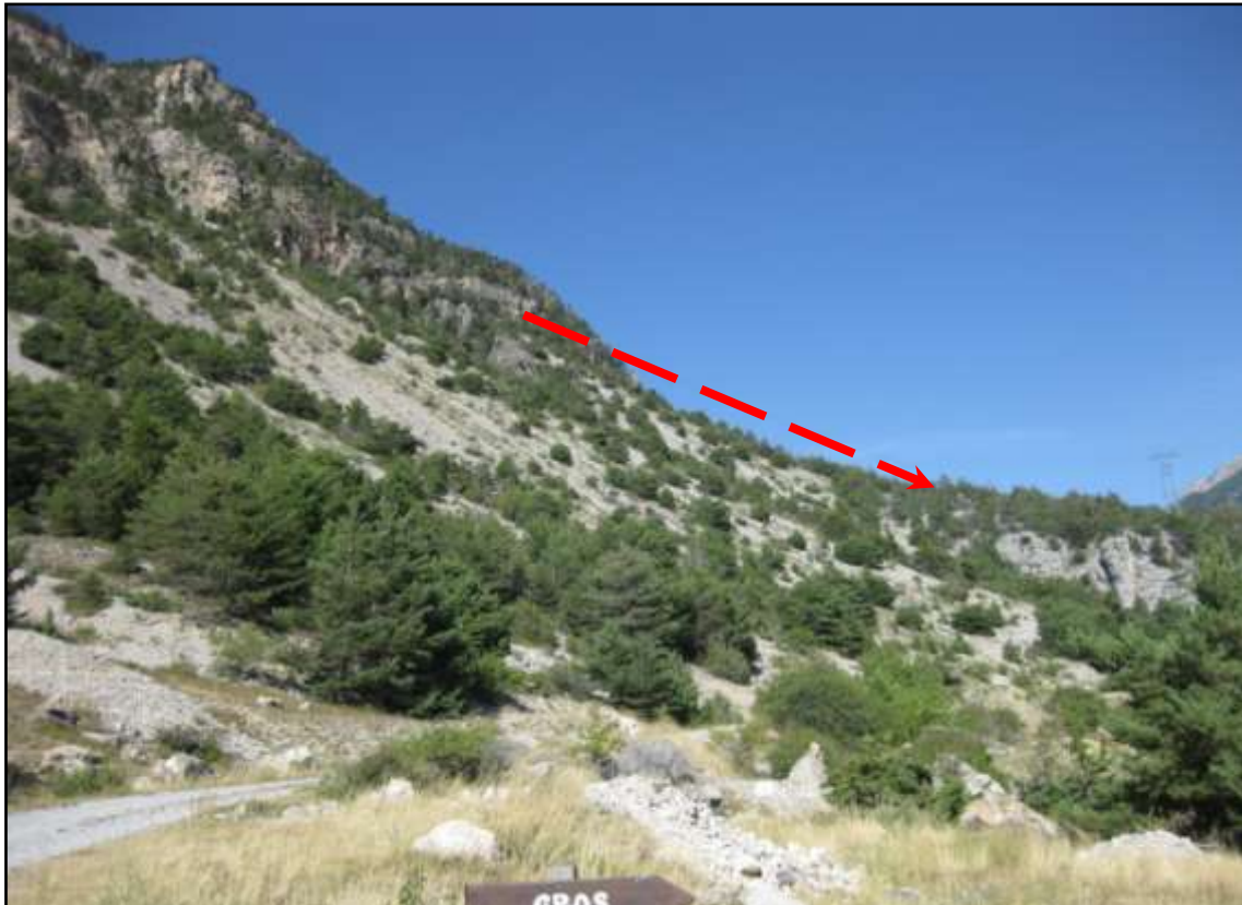
Figure 63 : Glissement près du hameau de Gros (masse glissée) [Source : IMS RN ]
