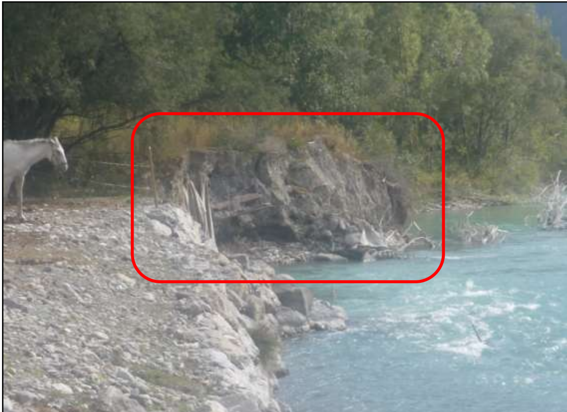
Figure 69 : Erosions de berges le long de la Durance (au niveau de la base de loisir) [Source : IMS RN ]
