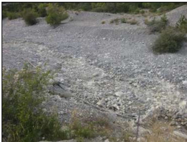
Figure 18 : Cône de déjection du torrent du Merdanel [Source : IMS RN ]
