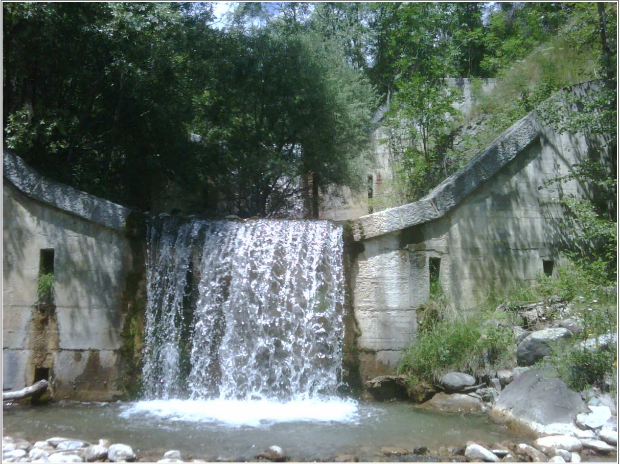
Correction torrentielle active (3 barrages RTM) sur le torrent de Sachas
