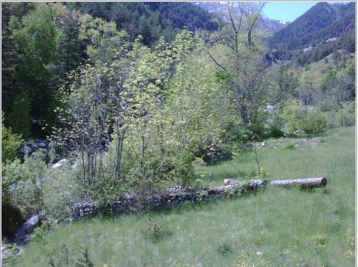
Épis en gabion à l'amont du cône de déjection du torrent du Gros-Riou.
