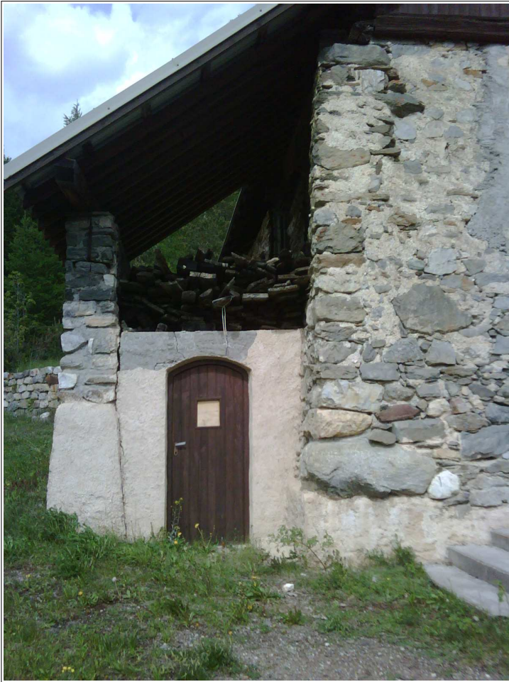
Traces de déformation sur le bâti en raison des glissements de terrain à l'amont de Rocher-Baron
