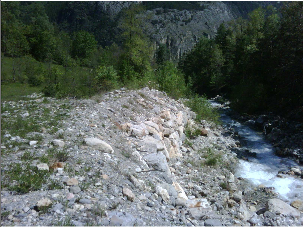
Digue en produits de curage à l'amont du cône de déjection du Gros-Riou.
