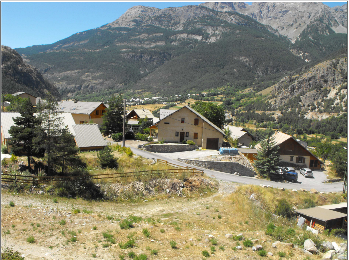
Glissement ancien du Villaret : Les maisons au premier plan sont implantées sur un paquet glissé.
