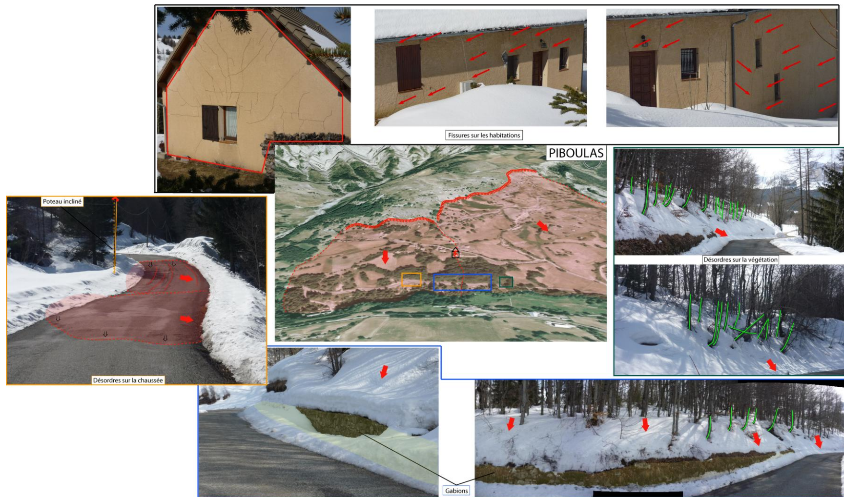
Figure 36 : Glissement de versant de Piboulas (source IMSRN)
