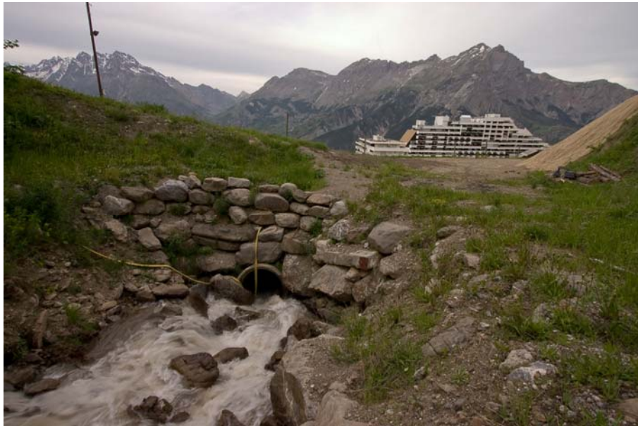
Le busage des Eyssalarettes en amont de la station, juin 2009
