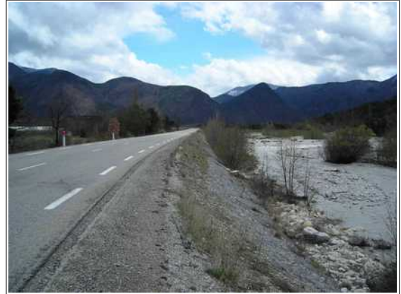
La RD937 aménagée dans le lit majeur de la Béoux joue également un rôle d'endiguement. Sa largeur importante devrait s'avérer efficace pour contenir les crues. Seul le talus intérieur constitué par endroit de gabions peut s'avérer sensible aux affouillements.
