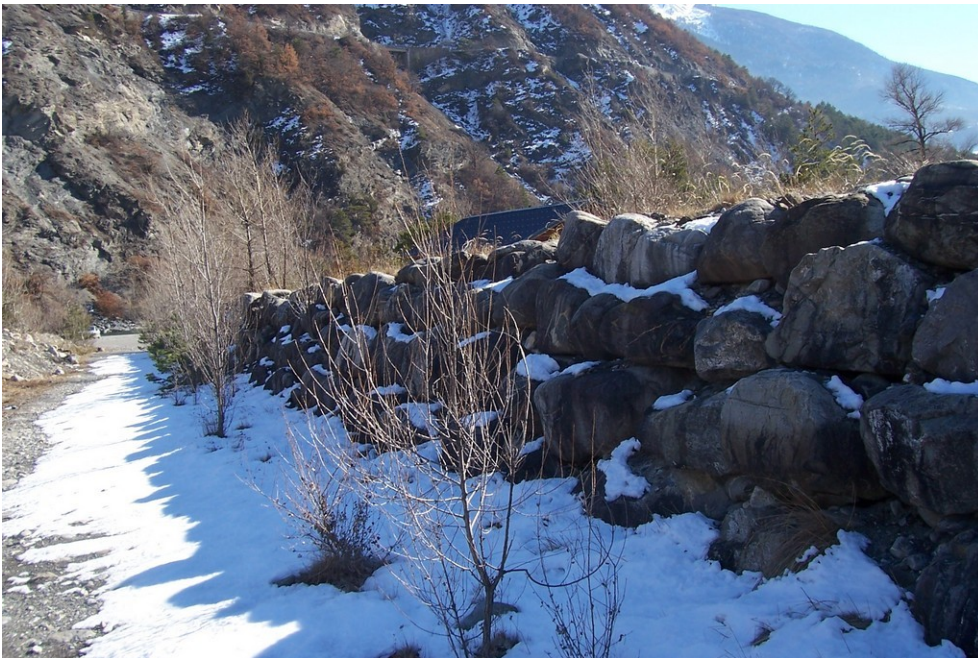
Illustration 16: Digue de protection des installations de loisir aquatique à la confluence du Rabioux et de la Durance
