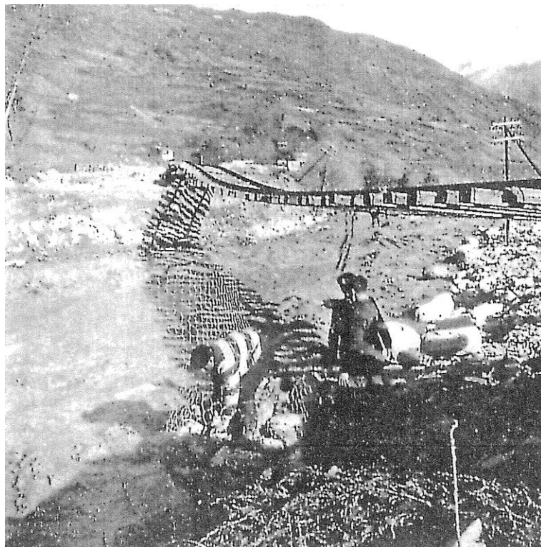
Illustration 12: dégât de la crue du 16 novembre 1963
