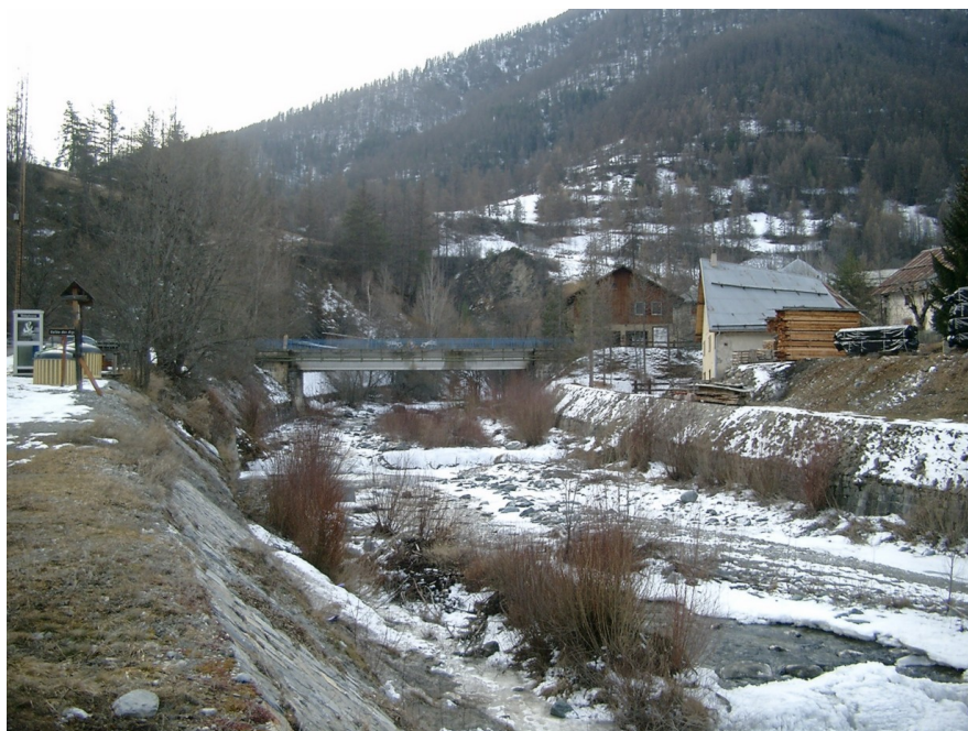
Photo 03, 04 et 05 : le chenal canalisé de l'Aigue Blanche à Ville Vieille
