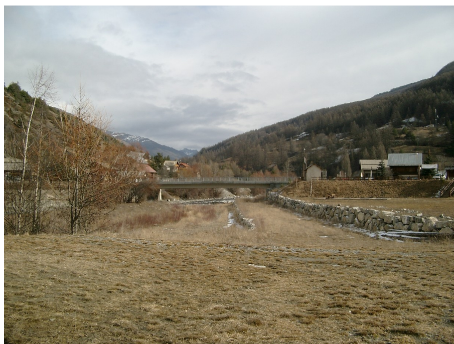
Photo 9 : secteur aménagé pour les dépôts d'embâcles et de sédiments en aval du pont de la RD 5
