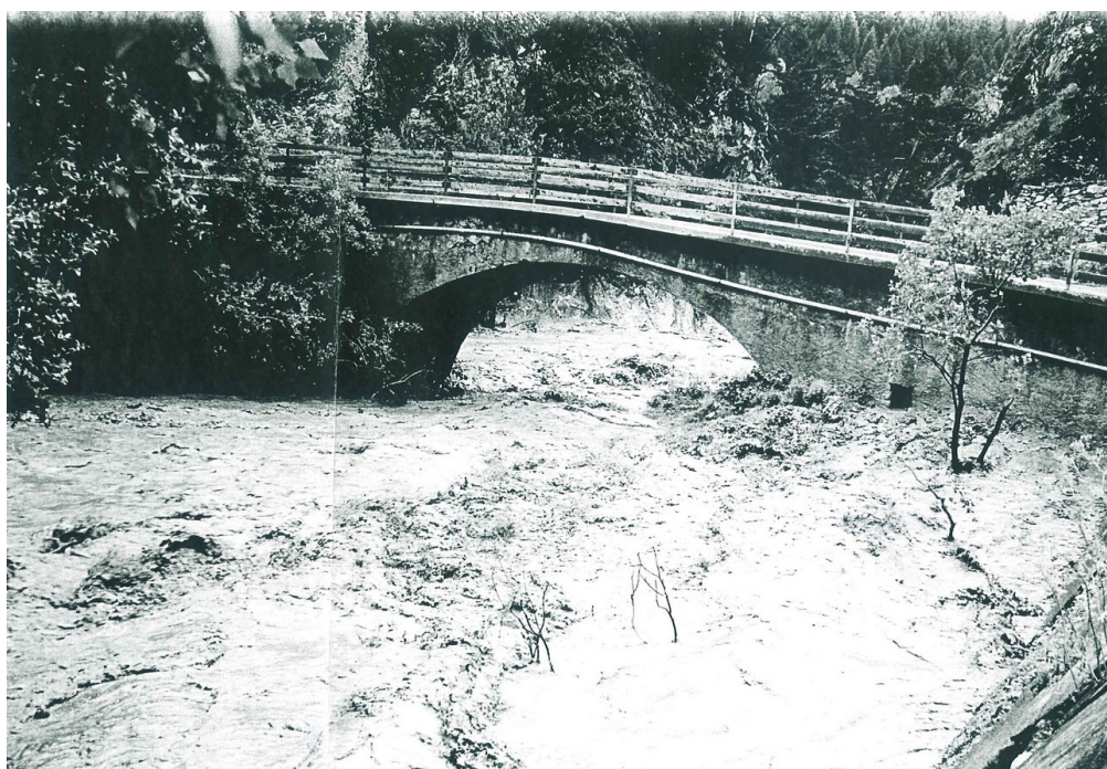
Crue de juin 2000 ; pont de Château Queyras.
