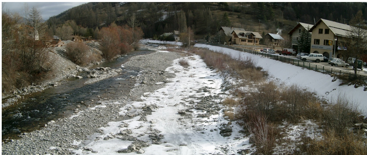
Photo 8 : Guil canalisé en amont du pont de la RD 5 ; digue rive gauche en bon état et berges rive droite érodables.
