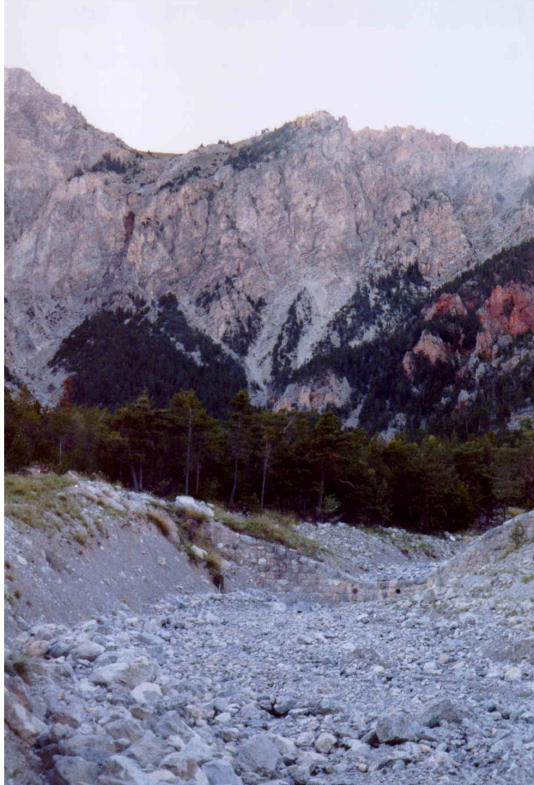
Photo 7 – Seuil en pierres maçonnées sur le torrent de Malefosse
