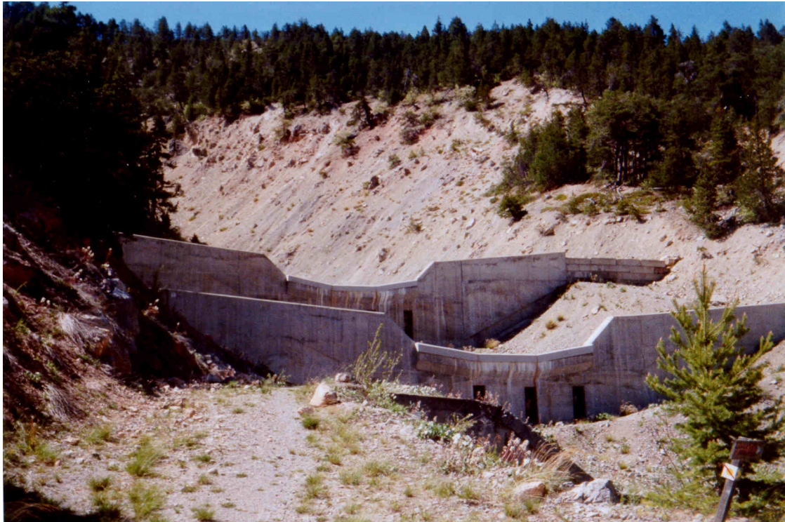
Photo 8 – Barrages sur le torrent de la Ruine
