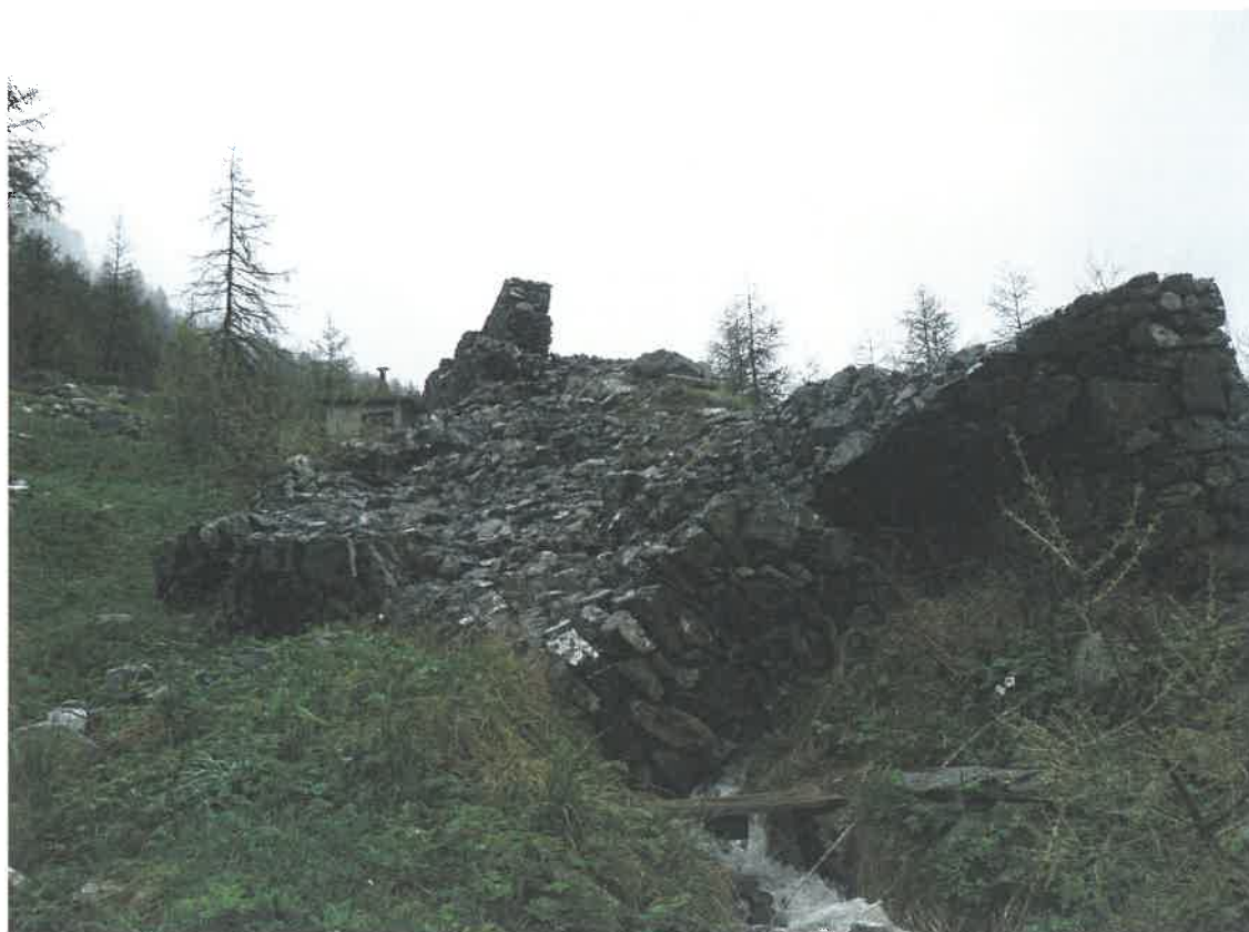
Illustration 5.22.: Tourne paravalanche en gabions effondrée (photo prise le 05/2008) aux chalets de Lacha, censée initialement protéger le chalet de feu M. Rabinovitch. L'avalanche de la Raoute (n°119 de la CLPA) serait descendue plusieurs fois au XXe siècle, la dernière fois avant 1966, et aurait occasionné des dégâts jusqu'à la RD 3011 (Grange Perret), le souffle étant ressenti jusqu'à la Clarée.
