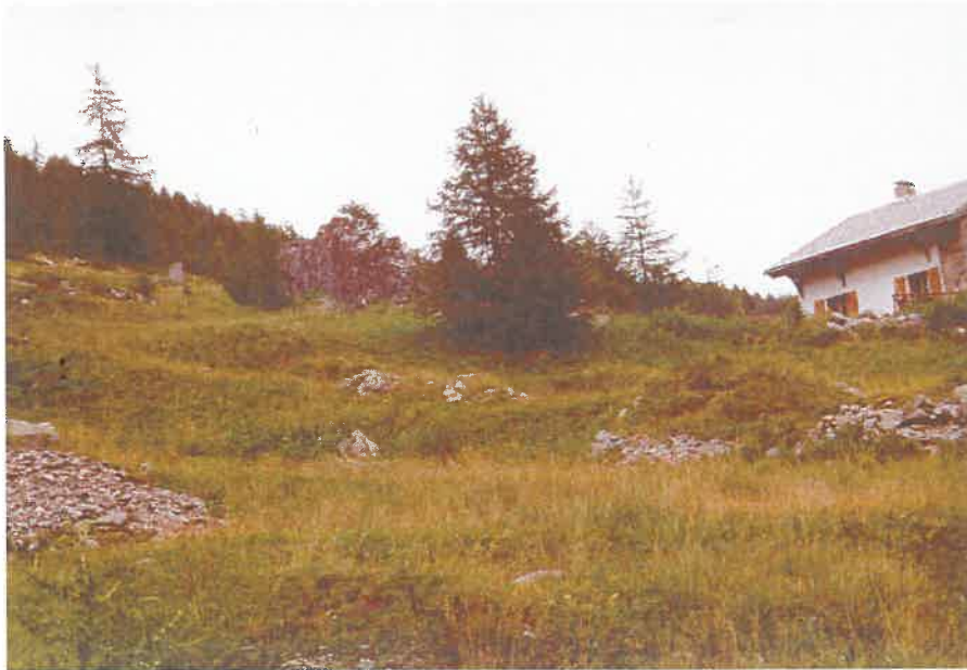
Photo 5.25 – Tourne paravalanche en gabions aux Chalets de Lacha en 2002
