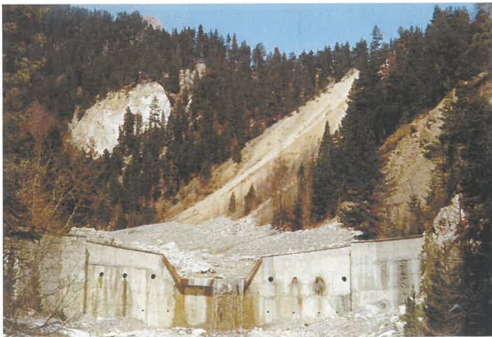
Photo 5.26 – Vue depuis l'aval du seuil de correction torrentielle amont situé sur le torrent des Liches.
