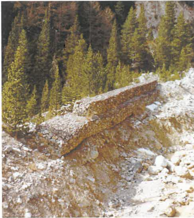
Photo 5.29 – Digue en gabions sur le torrent du Roubion.
