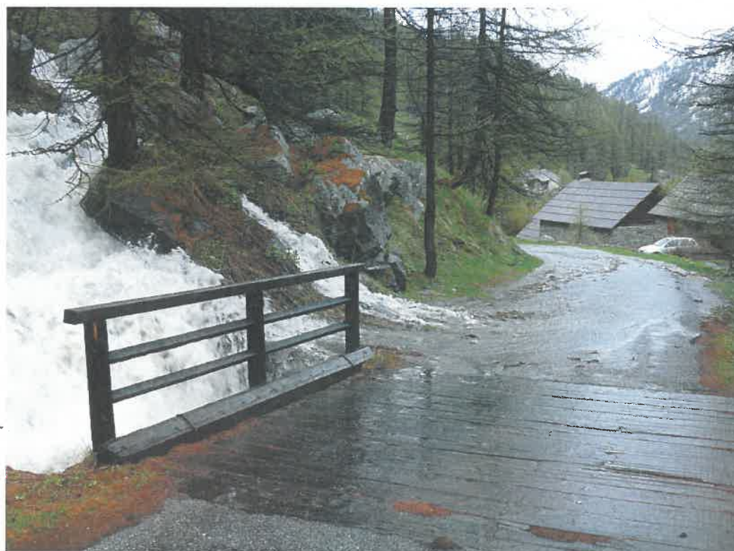
Illustration 5.15.: 26 mai 2008 – Torrent du lac Laramon ; débordements d'eau claire sur la RD 3011 et sur les chalets du jadis plus en aval (non inondés).
