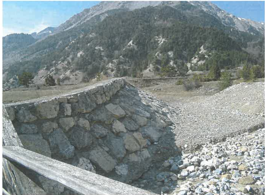
Photo 5.27 – Vues depuis l'aval de la digue rive droite du Roubion en amont du centre de vacances
