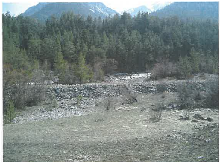
Photo 5.30 – digues latérales à la Clarée, édifiées en tout venant dans l'emprise du lit majeur. Ici, en aval de la confluence Roubion/Clarée
