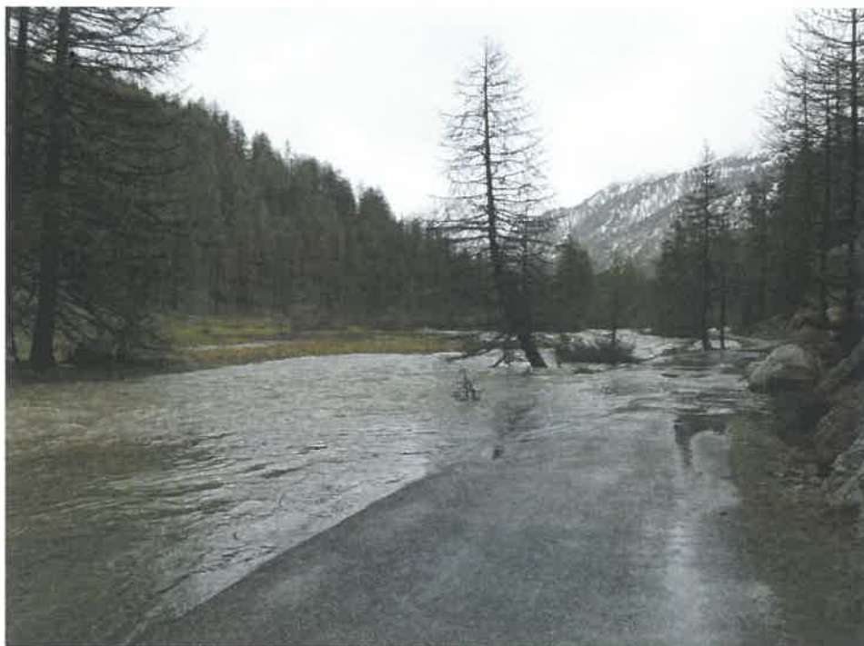
Illustration 5.1.: 26 mai 2008 – débordement de la Clarée sur la RD3011 en aval du Jadis
