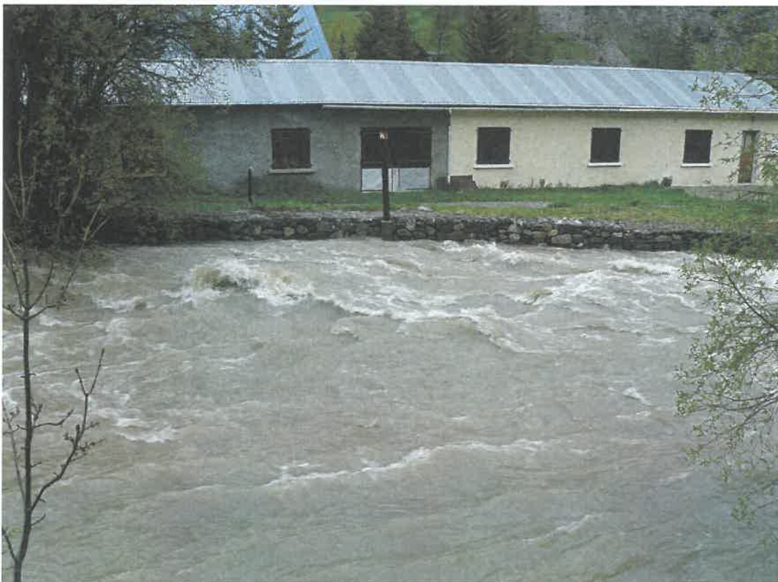
Illustration 5.6.: 26 mai 2008 – la Clarée en aval du pont de l'Outre. La revanche de la digue rive gauche est de 30 cm.
