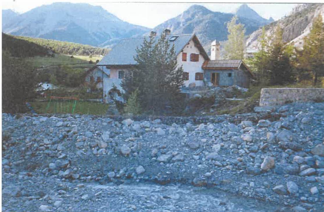
Photo 5-15bis – Engravement du lit et du cône de déjection du torrent des ACLES suite à la crue du 15 octobre 2000
